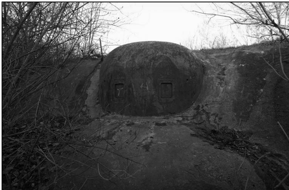
Kopule pro sólo těžký kulomet vz. 37 pěchotního srubu B-S 13 (Radek Hrabčák 2007)
