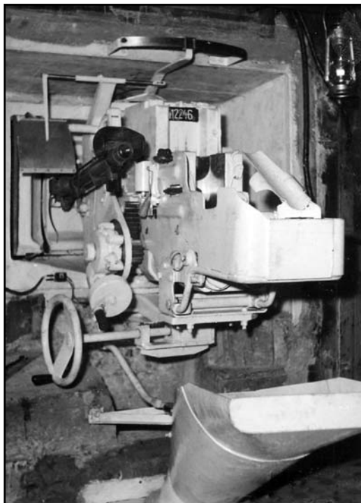
Zkoušky prototypu 85mm PvK vz. 44/59 ve zkušebním objektu CE Jordán. Stejný kanón byl osazen i ve srubu B-S 13 (VHA)
