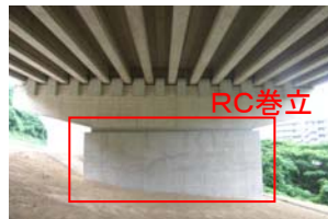
一般国道53号首部高架橋 (H23.7完成)
