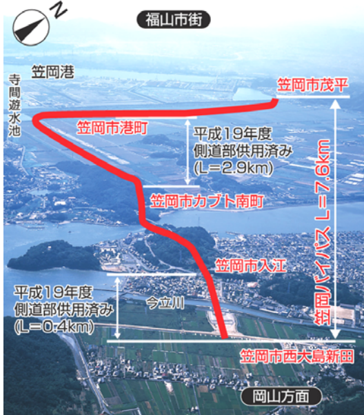
起点側より西方面(福山方面)を望む
