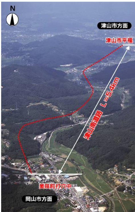
起点側より北方面(津山市方面)を望む
