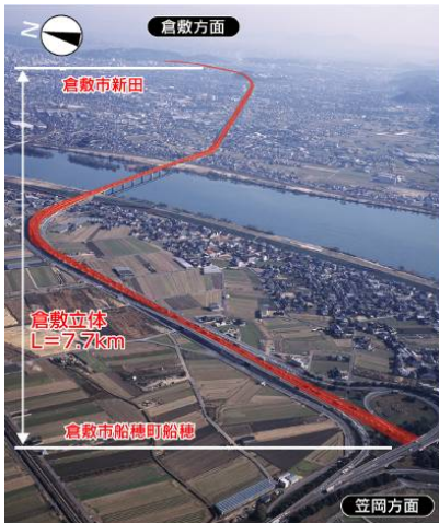
終点側より西方面(倉敷方面)を望む
