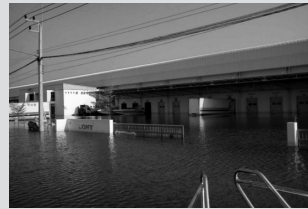
【SSCS-T】約1.7mまで浸水。1日5cm程度しか水が引かない状況が続いた。
