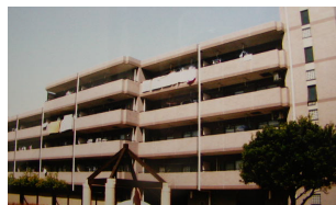
マンション修繕工事
