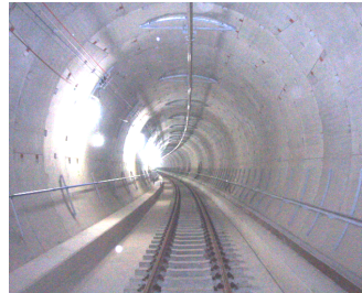
剛体電車線 施工状況
