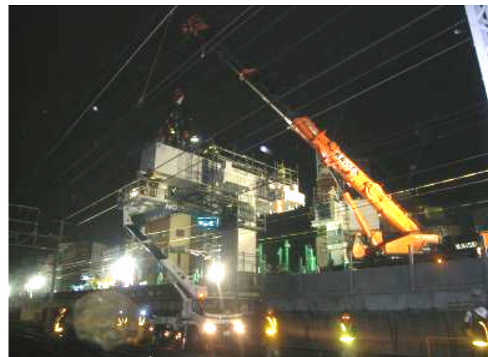
土木橋脚新設に伴う 電車線支障移転作業 東京～上野間
