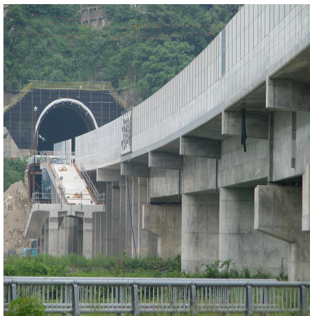
糸魚川付近 中浜トンネル
