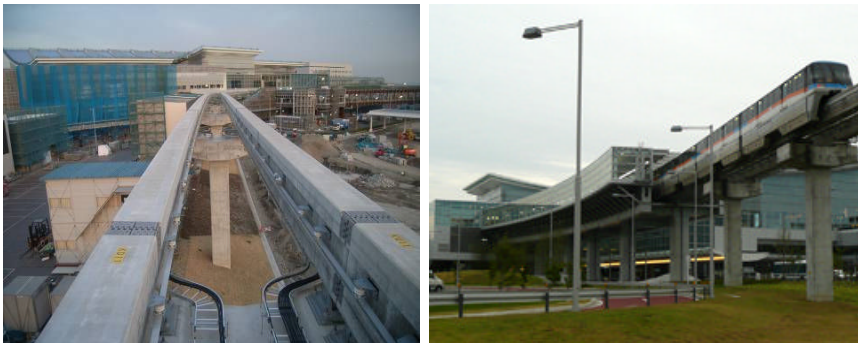
東京モノレール(株)羽田空港国際線ビル駅設備工事 (2010.10.21開業)
