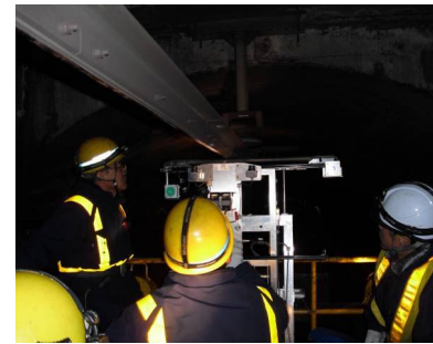
モーターカー作業台上での測定状況
