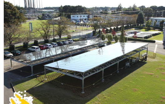
中央学園太陽光発電設備 (千葉県柏市)
