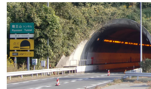
西日本高速道路 山陽自動車道 龍王山トンネル
