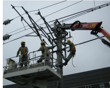
可動ブラケットを電車線柱に取り付ける作業状況
