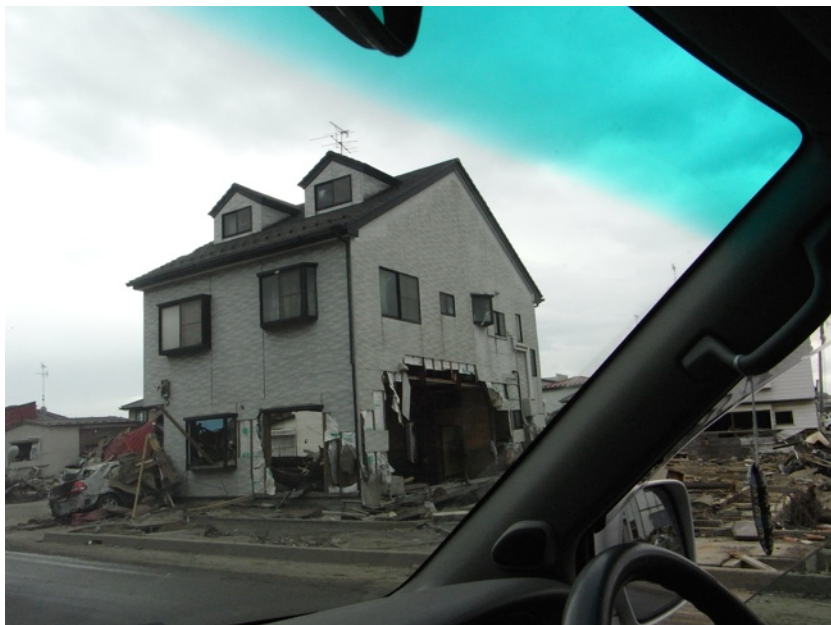
石巻市湊近辺 左：海岸方向 津波による破壊。
