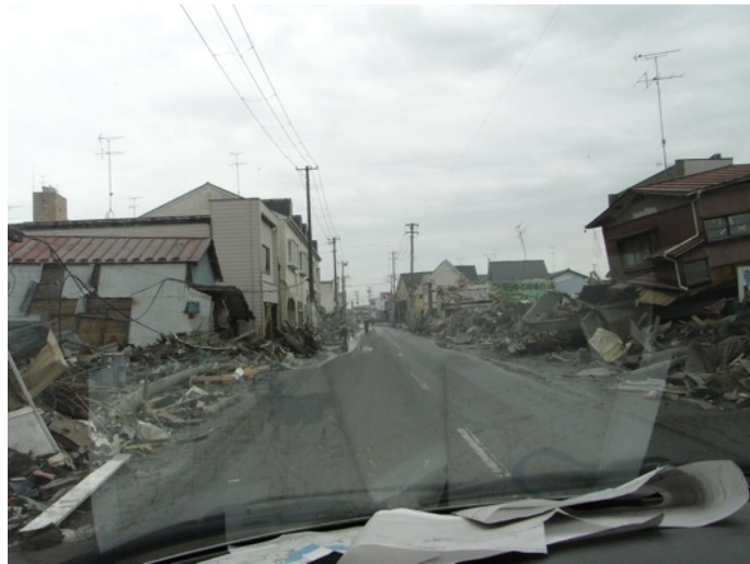
石巻市湊近辺 398号線両側 被害が大きい。
