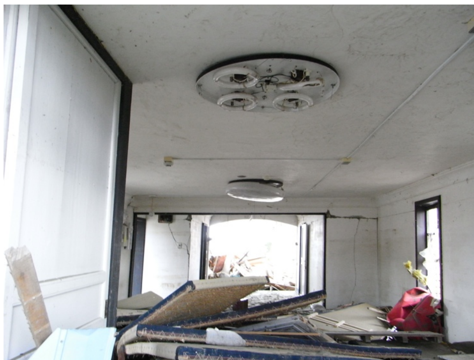
内部 背面より正面方向を見る。
