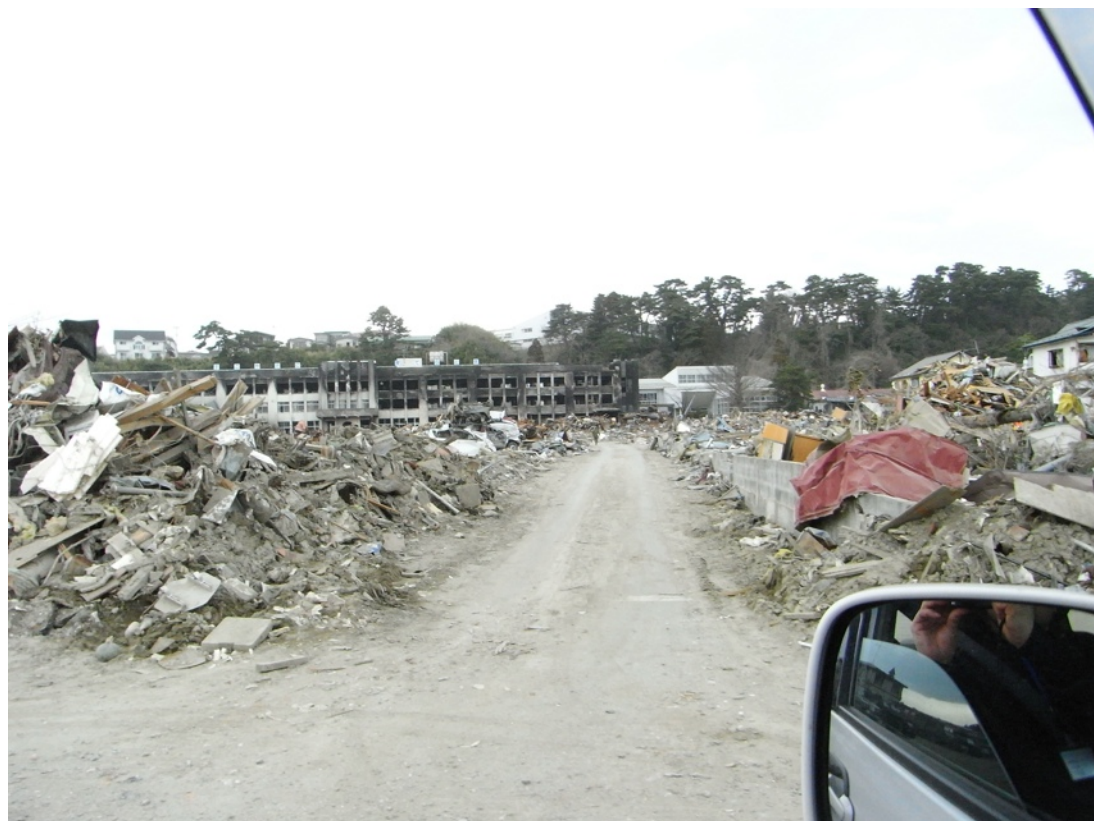
石巻市南浜町 被害がすさまじく、街区の境目が不明となっ てしまっている。
