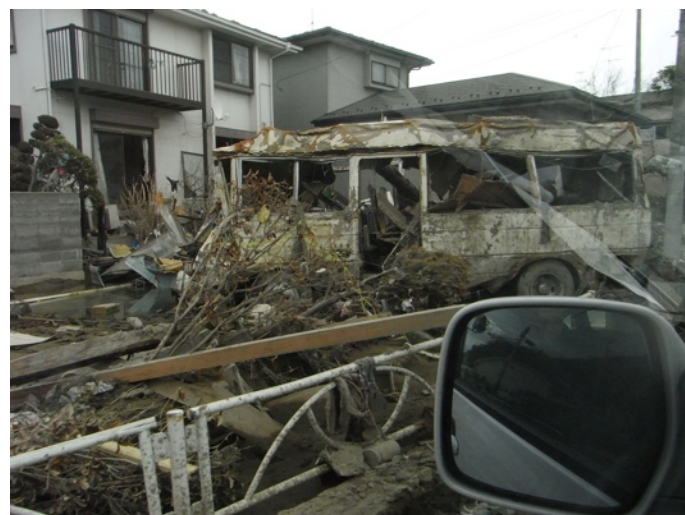
石巻市湊近辺 建物が残っても1階部分の被害は大きい。 小路に入った山手側でやや被害軽微なものが見られた。
