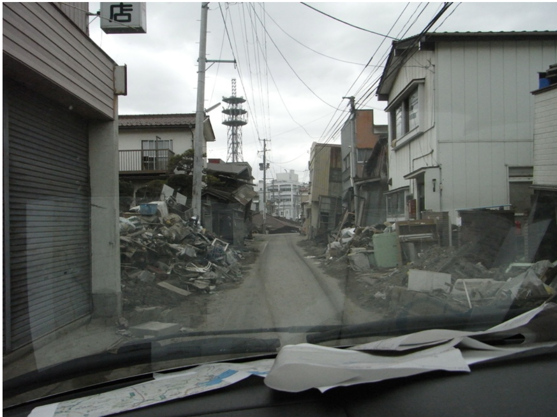
石巻市門脇町 密集した町内では、家屋倒壊により 数カ所で道が塞がれている。
