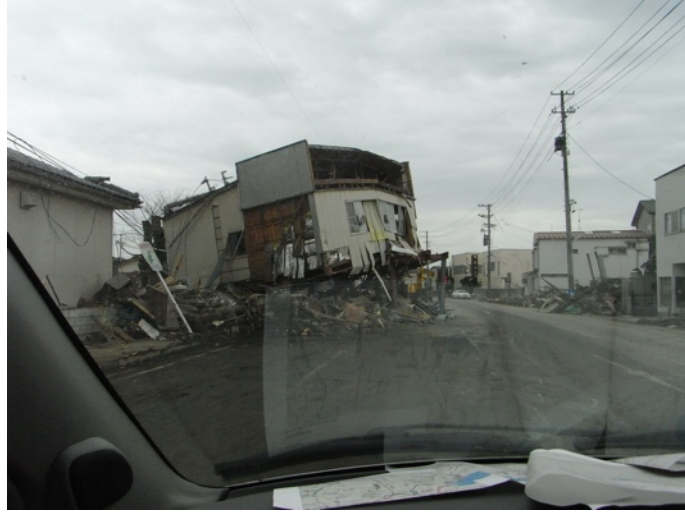
石巻市湊近辺 1階が破壊され道路に崩れている。
