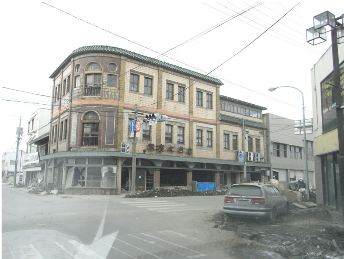
石巻市中央3丁目 陶芸観慶丸 1階店舗 浸水による被害。
