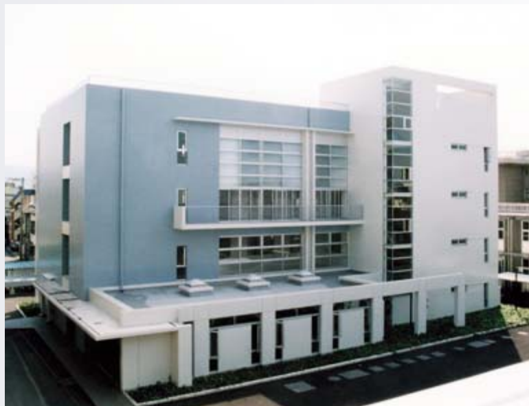
創立70周年記念事業のⅡ期工事「C棟」が完成した
