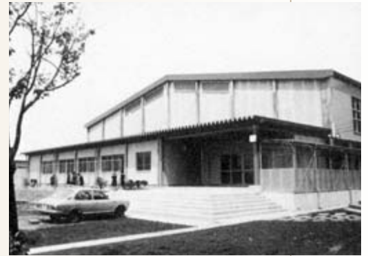
完成した新体育館
