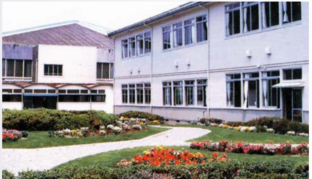
新校舎の建設のため、取り壊される第二校舎と中庭
