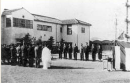
第4校舎（現D棟）増築の地鎮祭
