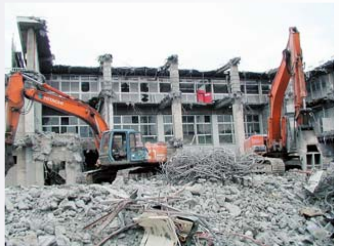
9月 旧校舎の解体工事
