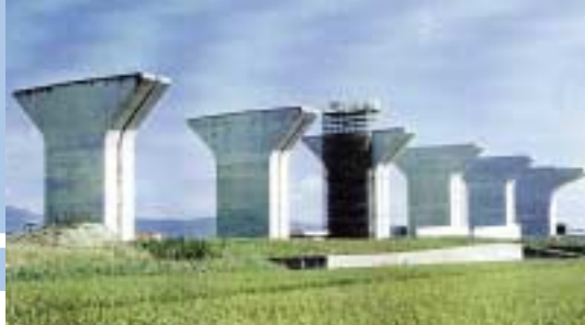
工事の進む京奈和自動車道(田原本町付近)
