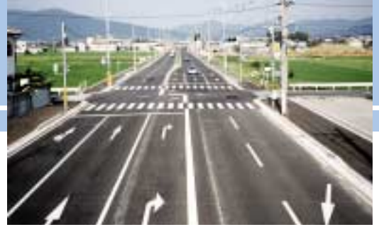
中和幹線常盤工区(檀原市)
