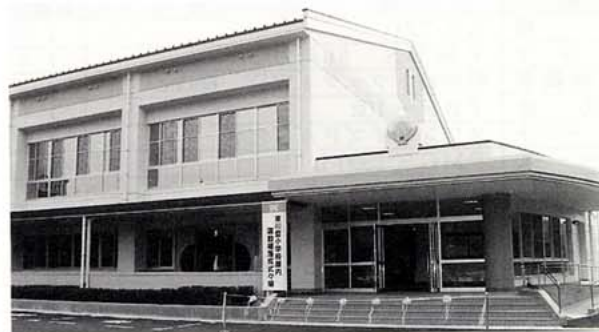
東川登小学校体育館
