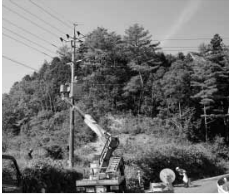
ケーブルテレビ敷設工事
