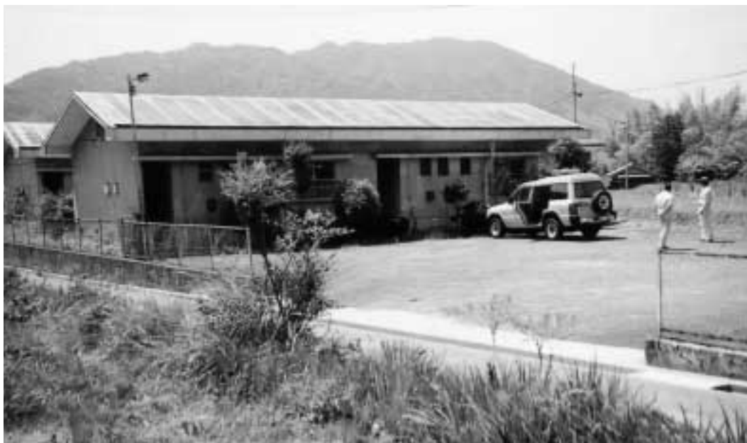
旧阿東土木事務所職員住宅（生雲地区）
