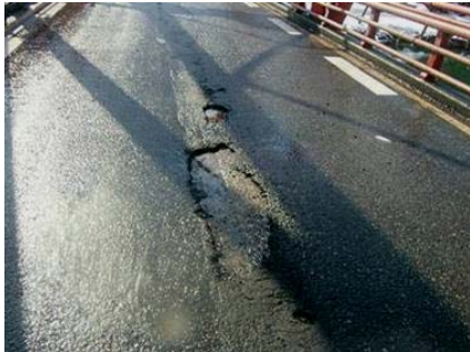
補修工事の状況
