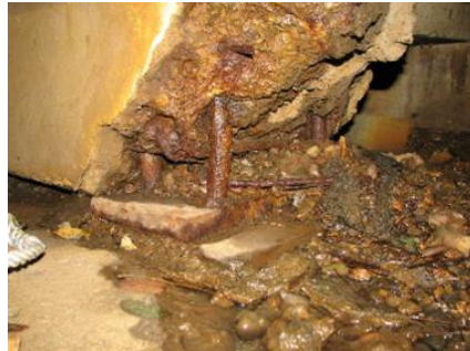
補修工事の状況
