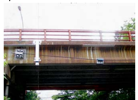
補修完了(外ケーブル設置)
