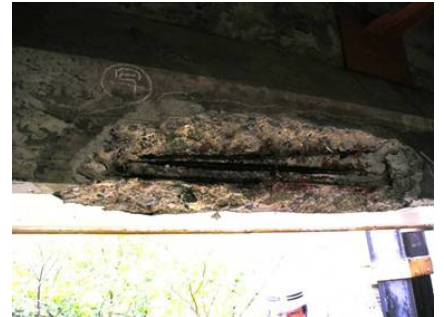
補修工事の状況(断面修復)
