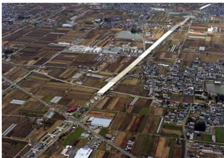
高架橋工事の進む十六面地区(田原本町)
