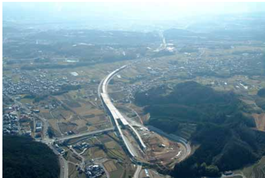
高架橋工事の進む居伝地区（五條市）
