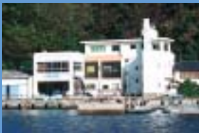
野母崎樺島地区公民館・樺島連絡員事務所
