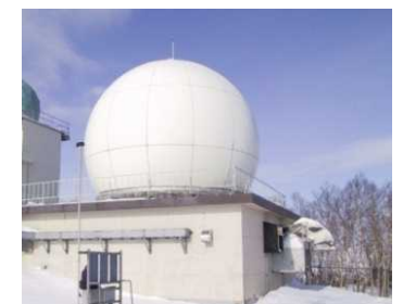
写真は、第301沿岸監視隊 (稚内) に設置している沿岸監視装置
