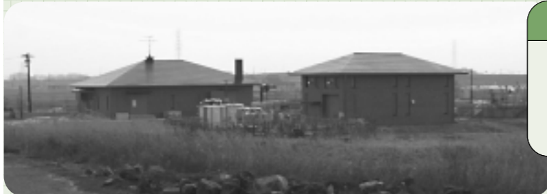
(仮称)大月運動公園建設予定地 = 大月地内にて
