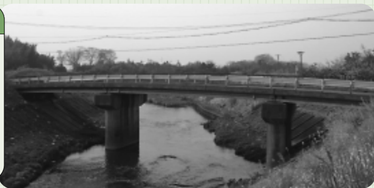
架け替えられる下犀川橋 = 牛牧、横屋地内にて
