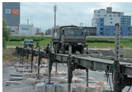
81式自走架柱橋を架設し通過する災害派遣車両
