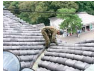
天守閣の屋根先で作業を行うレンジャー隊員
