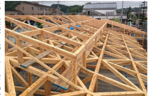
間伐材を使用した拡張アンカー工法＝大分西部
