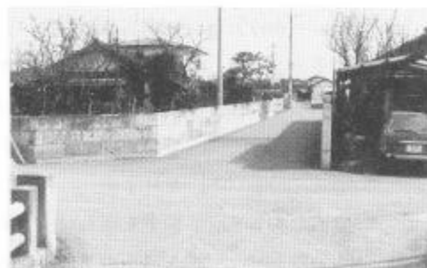
大崎商舎旧入口付近・西より望む（石井町）
