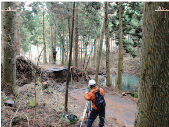
写真1 トータルステーションを用いた測量風景。
