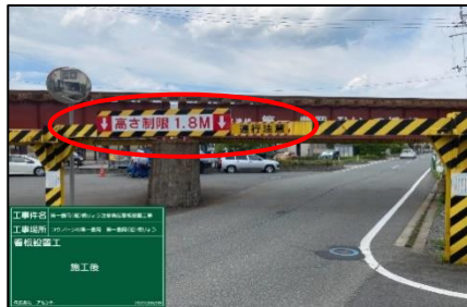
令和4年8月9日桁下防護工注意看板取替設置
