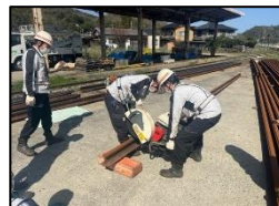
○レール切断機・穿孔機取扱い訓練切断訓 令和5年3月28日 教育人数6名
