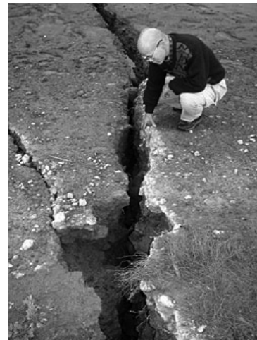
写真5 大きなクラック
