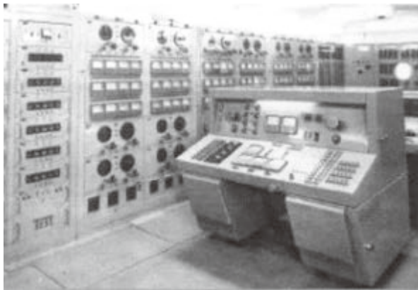
図 10.12 関西電力の交流計算盤 (関西電力総合技術研究所パンフレット1984年)
