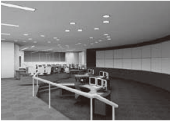
図 7.5 東北電力中央給電指令所の新しい司令室 (2002 年) (グッドデザインホームページ)
