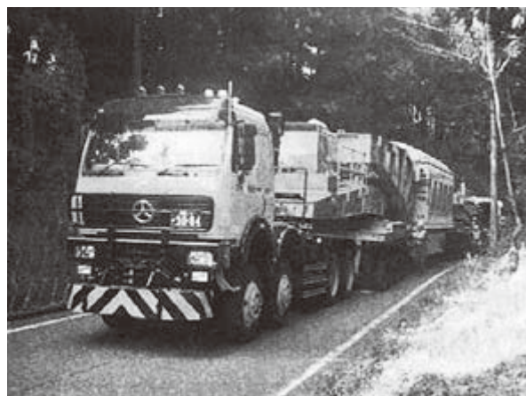
図 6.4 大容量変圧器の輸送の例
