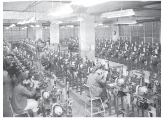
図 6.63 コイル製造工場 5)
