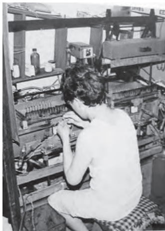
図 5.10 小形電球の製造状 (品川歴史館資料より)
