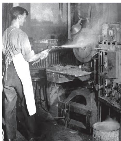
図 6.54 スエージング作業 (1925年頃) 15)
