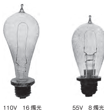
図 3.3 八幡の竹を使ったエジソン電球 1)
