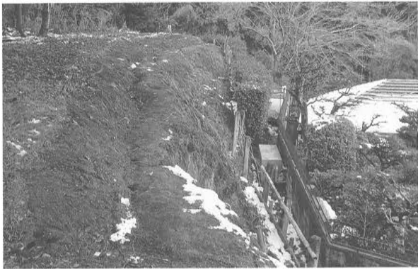
写真1 桃山陵墓地 調査箇所全景 (掘削前)
