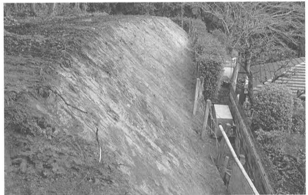
写真2 桃山陵墓地 調査箇所全景 (掘削後)
