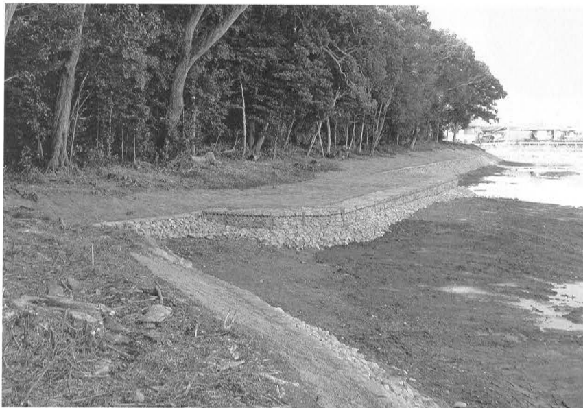
写真8 宇度墓 北造出周辺施工状況
