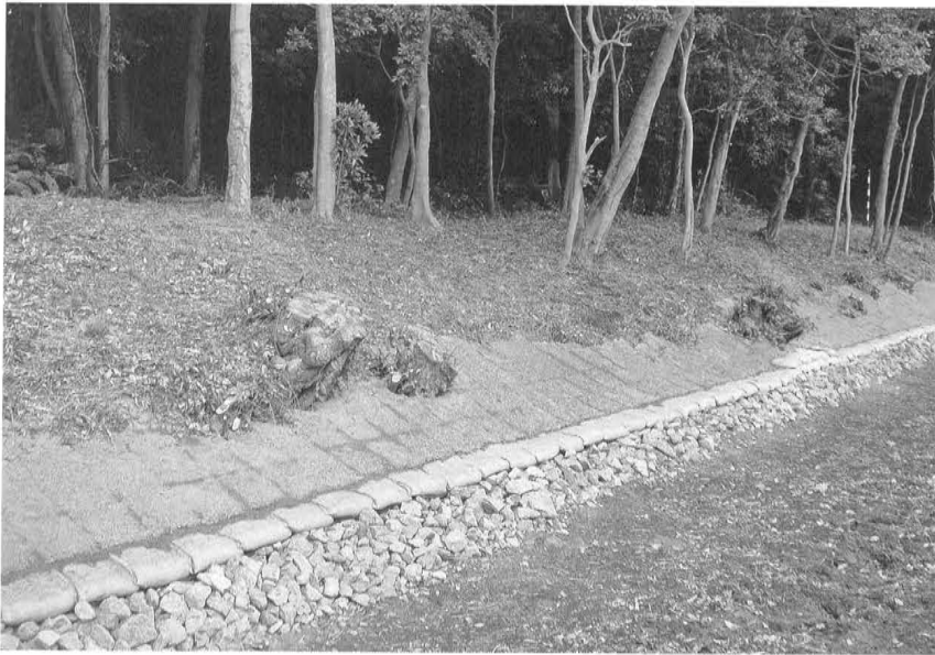
写真7 宇度墓 墳塋護岸施工状況（南濠）
