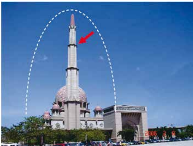
Rys. 4. Minaret meczetu w Putrajaya (wskazano miejsce trafienia pioruna) [10]
