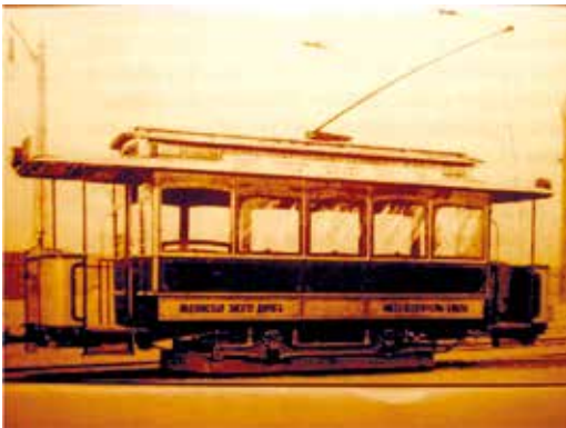
Rys. 29. Wagon silnikowy Herbrand VNB-125 . Łódź, 1898 r. [31]
