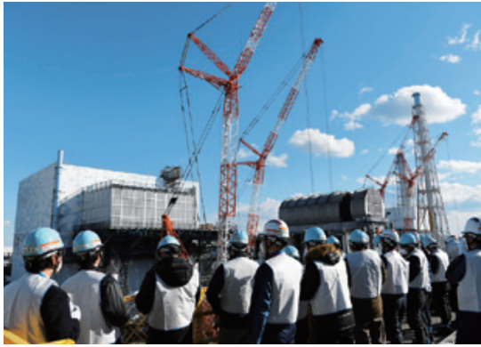
2号機(左)の開口部に構造物を、3号機の吹き飛んだ上部にカバーをとりつけている。まだ燃料取り出しの準備段階だ
