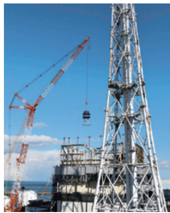
がれき撤去作業中の1号機(奥)と排気筒(手前)
