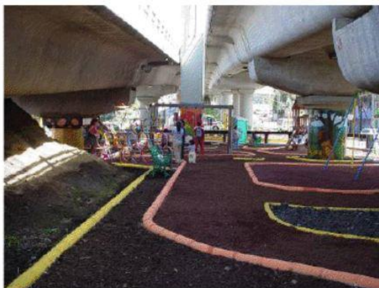
Área bajo puente, Col. Minas de Cristo, Álvaro Obregón
