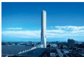
2007 エレベータ試験塔
