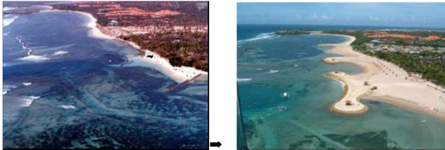
図 4-10 海岸侵食対策のための施設・養浜施工前後の比較 バリ島サヌール海岸
