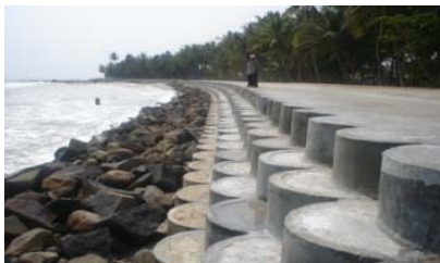
図 4-8 コンクリート海岸堤 Pantai Wameo, Kabupaten Bau-Bau, PUPR
