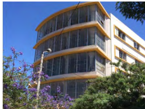
近代建築の意匠性を示す病棟外観
