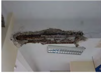
救急部門の改修中の梁
