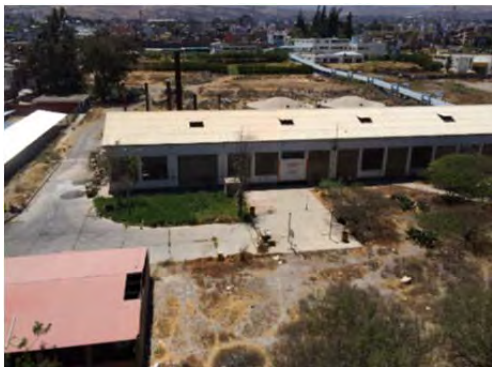
病棟屋上からボイラー棟を俯瞰
