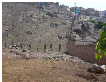
建替え用地裏山の浮石と近隣民家
