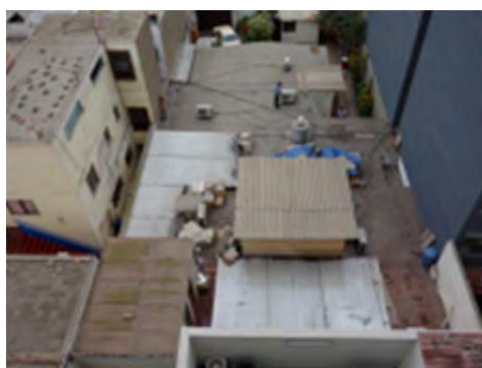
本棟から薬局棟を俯瞰（低層部と下の高層棟は繋がっていない）
