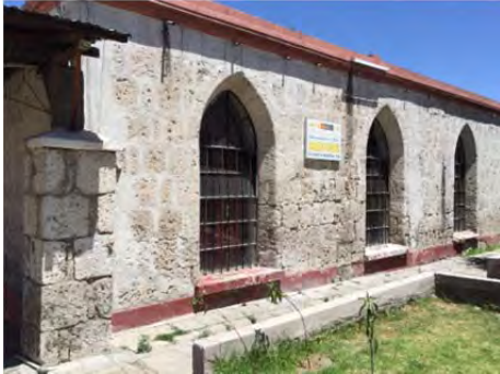
シジャール石組積造外観 (壁色の違いは補修跡)
