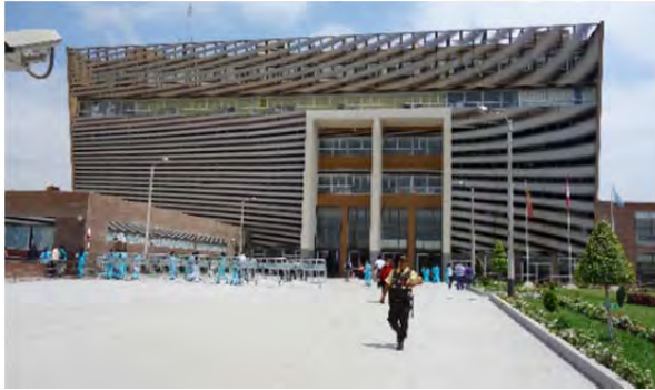
ランバイエケ州病院正面外観
