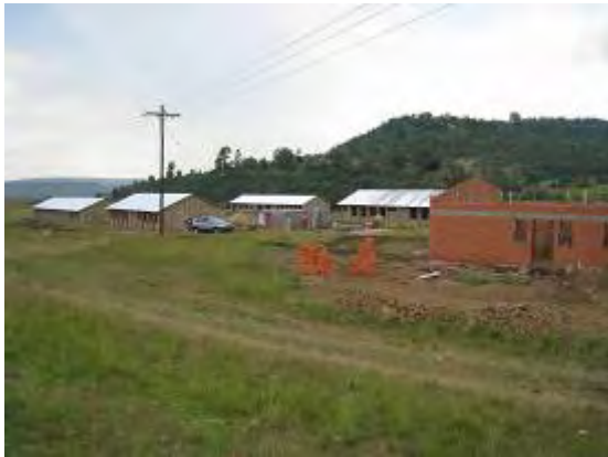
学校施設全景（Butha-Buthe） 左側の2棟が4教室棟・2教室棟、右側が教職員用住居。
