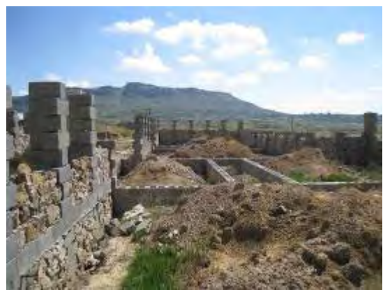
学生寮（Maseru） 外壁の柱と石積み工事の作業中。
