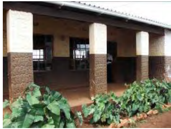
Hluti Central PS ( Shiselweni ) 建物は古いが構造はしっかりしている。
