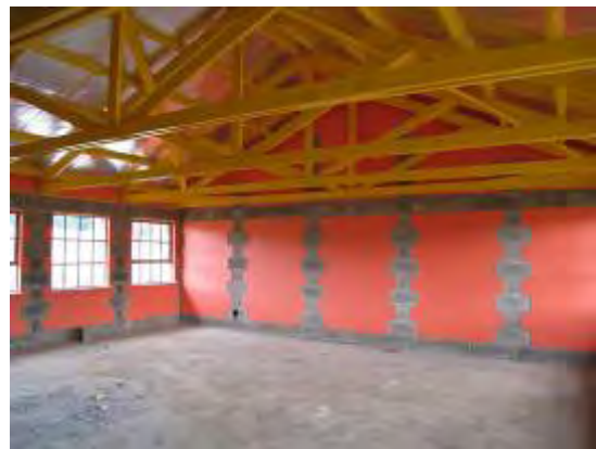
教室内部（Butha-Buthe） 壁のペンキ塗りが完了。壁の色は標準設計による。
