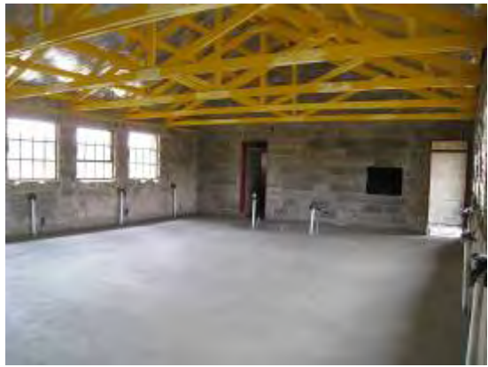
理科室内部（Butha-Buthe） 床コンクリート工事が完了。仕上がり状態がよい。
