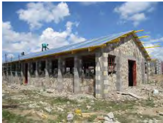
食堂・厨房棟（Maseru） 石積み外壁と屋根工事が完了。
