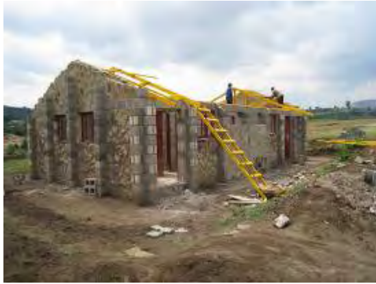
トイレ（Butha-Buthe） 木造トラスの設置作業中。
