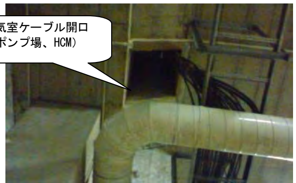
図 資料 5.8 ポンプ室開口部の施工例
