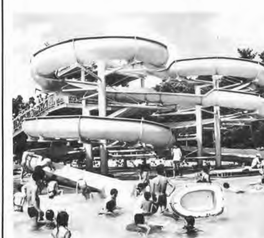
「スパイラル・ウォータースライダー」設置の様子
