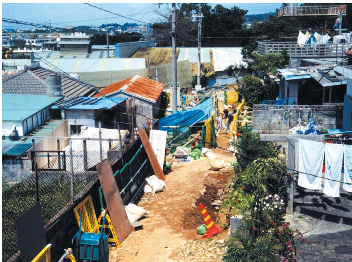
発掘現場の様子（東から）
