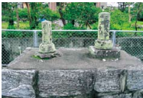
橋本（冷田川・橋西詰付近）
