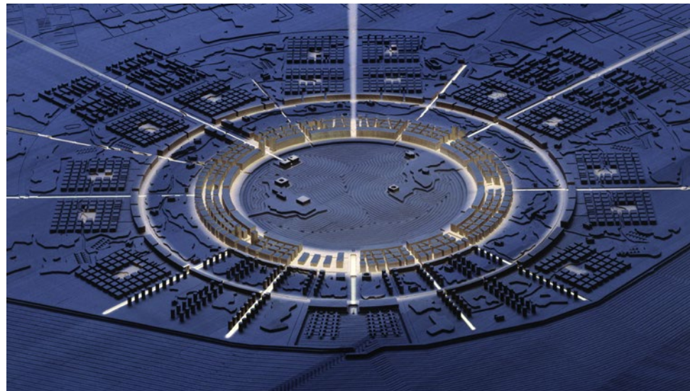
Links oben: Bau des Internationalen Messe- und Kongresszentrums Nanning, 2001, Foto: gmp, unten: Masterplan Lingang New City von gmp, Foto: Heiner Leiska
