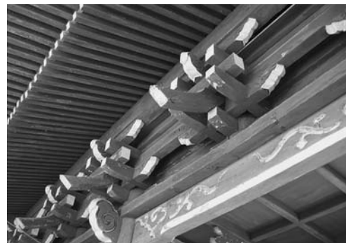
図16 下層の井桁組物
