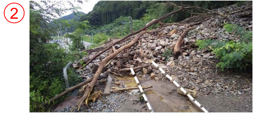
② 木曽平沢駅～贄川駅 251 k 950m付近 土砂流入 約1,000m 3
