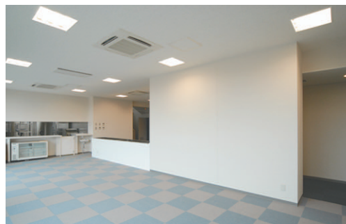
寮食堂の照明(FHP32W×3)
