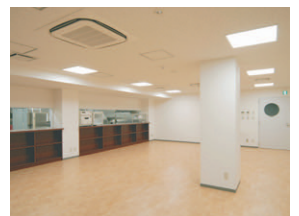
1軍クラブハウス食堂の照明 (FHP45W×4)
