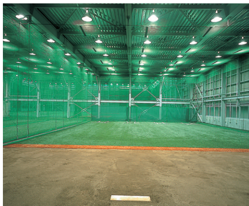
高天井用反射笠器具を採用した1軍ピッチング練習場の照明(MF1kW)
