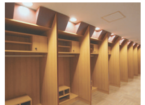
1軍クラブハウスのロッカールームの照明
