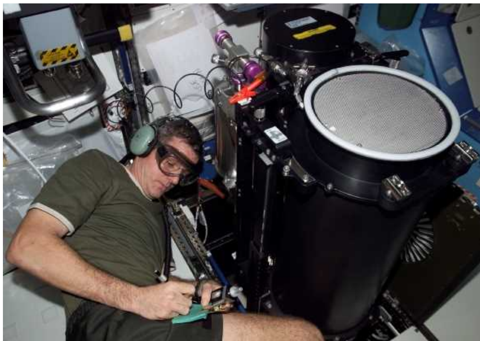
図3.4-3 米国の有害ガス除去装置(TCCS)の修理 (デスティニー内)
