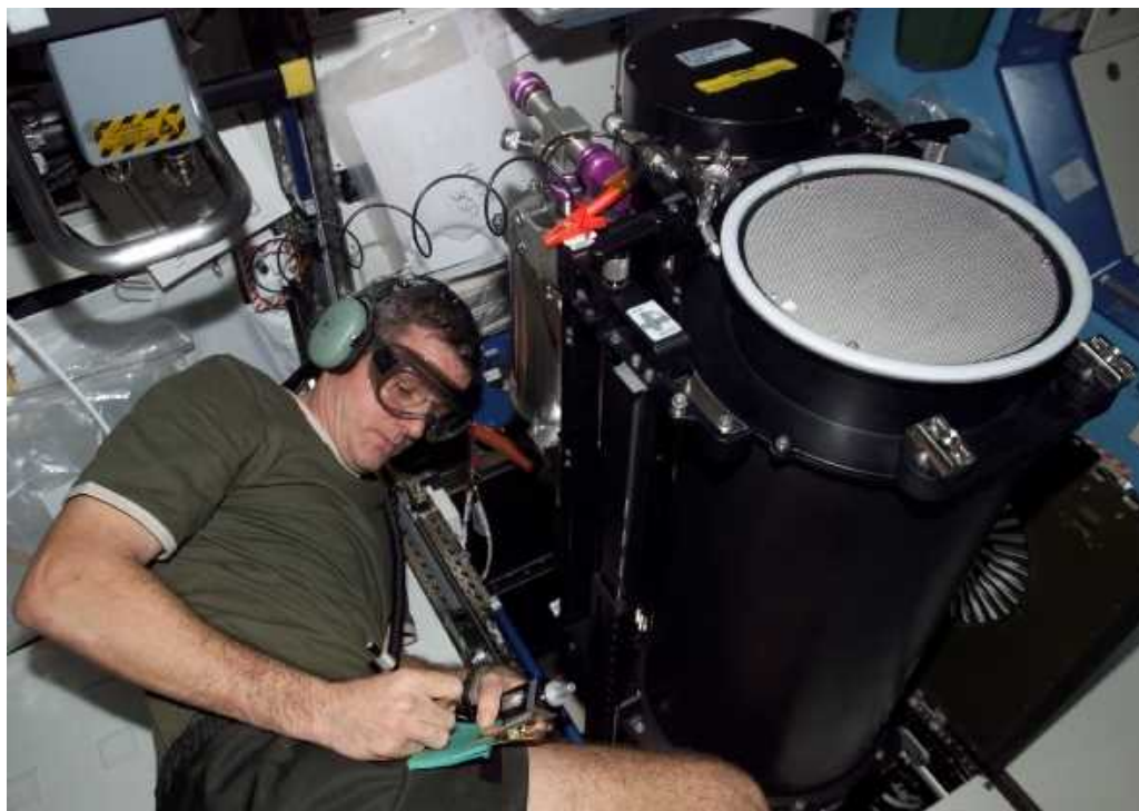
図4.2-6 米国の有害ガス除去装置(TCCS) (修理時の写真)
