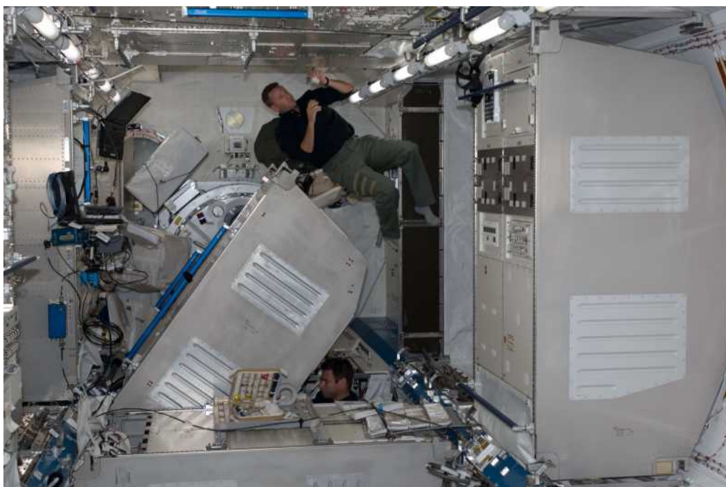
図3.4-7 「きぼう」内でのラックの搬入・設置作業
