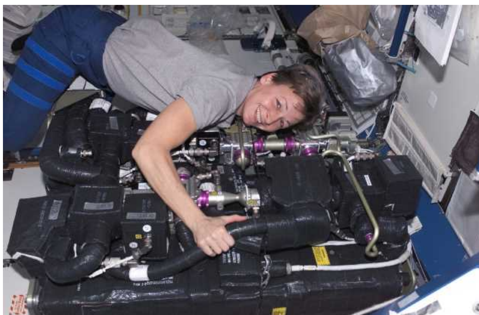
図3.4-2 米国の二酸化炭素除去装置(CDRA)の修理 (デスティニー内)
