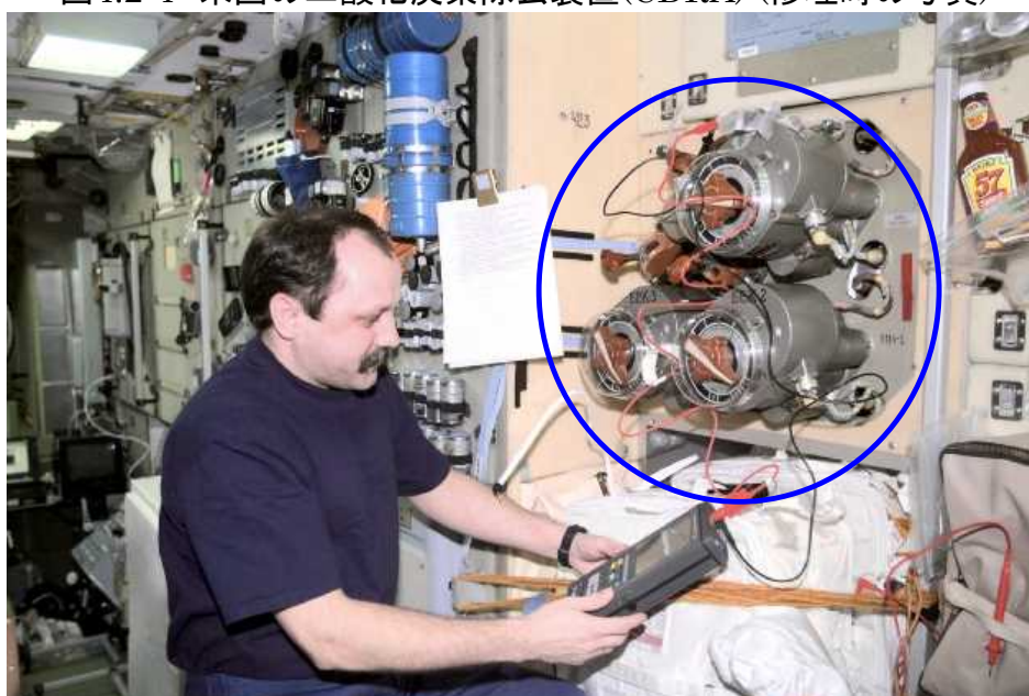
図4.2-5 ロシアのVozdukh (表面に見えているのはパネルのみで、本体はパネルの背後に収納)
