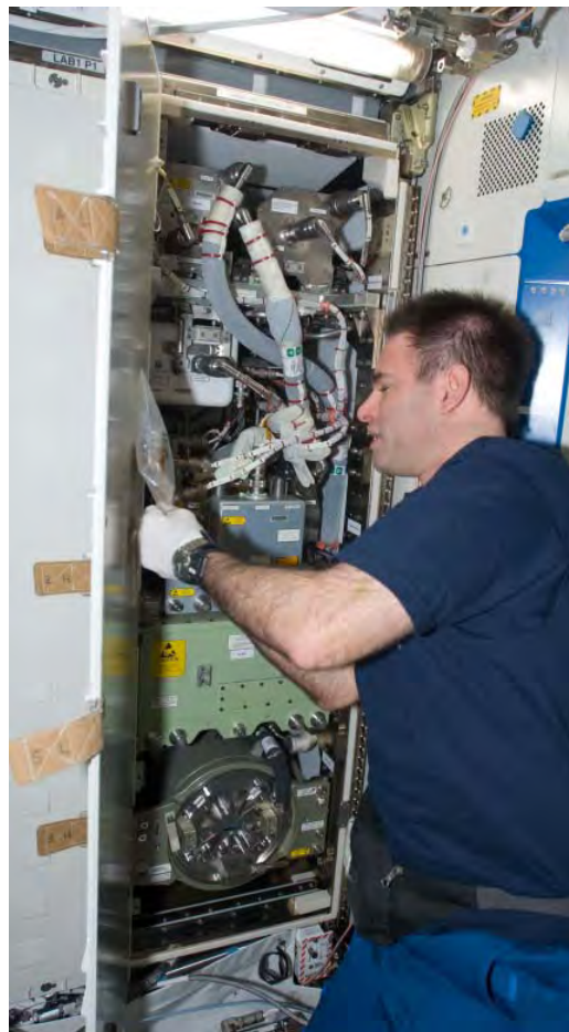
図3.4.2-3 米国の酸素生成装置(OGS)
