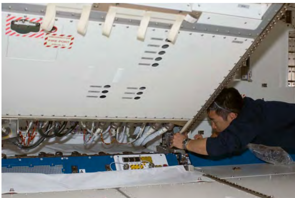
図3.3.4-11 「きぼう」内のラックの電力・通信・流体配管の接続作業
