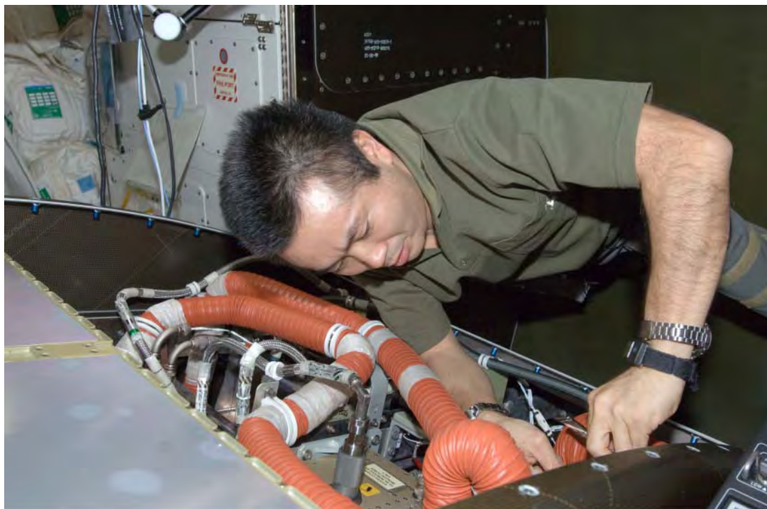
図3.3.4-15 ラック背面からアクセスしての修理・保全作業
