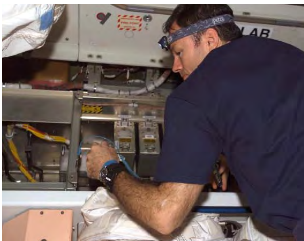
図3.3.4-4 遠隔電力制御モジュール(RPCM)の交換修理 (ユニティ内)
