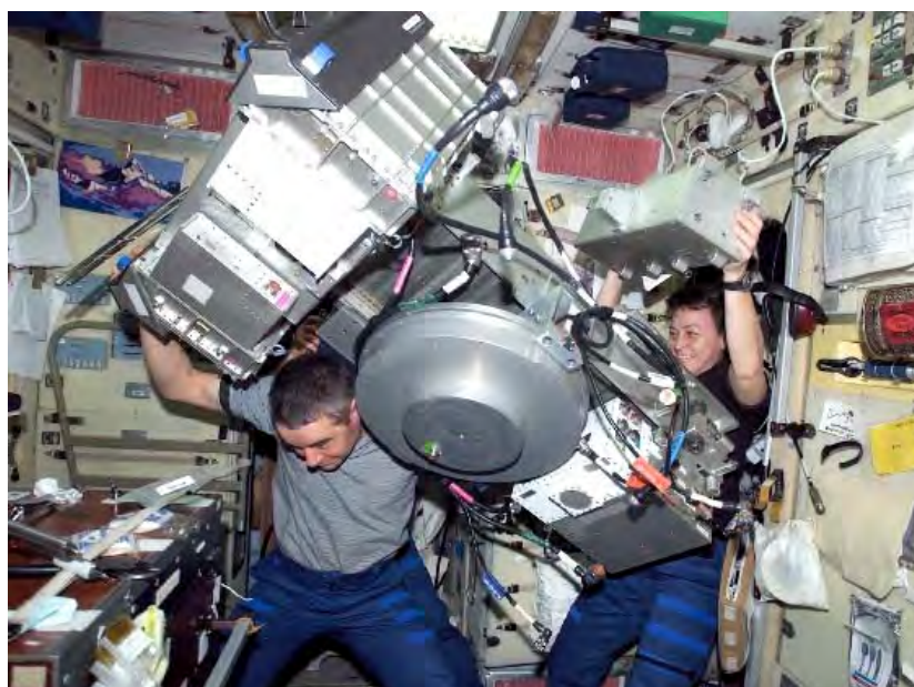
図3.3.4-2 TVISの修理(床下の機器を取り出した状態:2002年10月)
