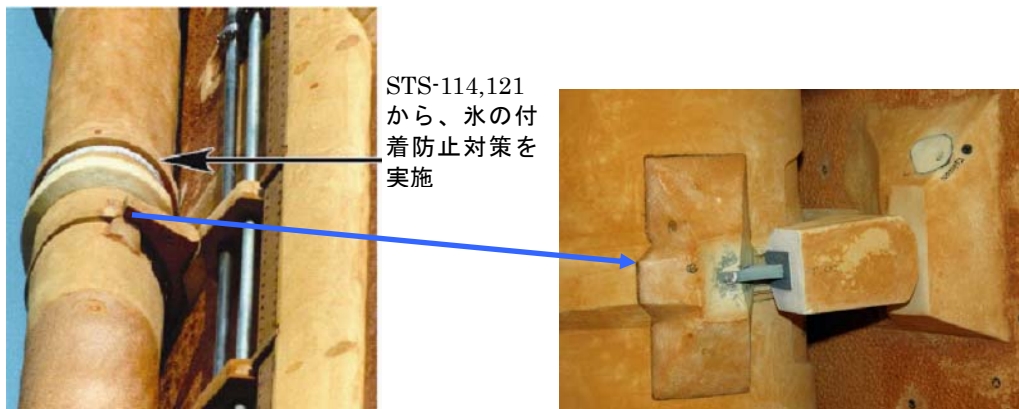
液体酸素供給配管の取付部 (右は断熱材の一部を切除した状態)
