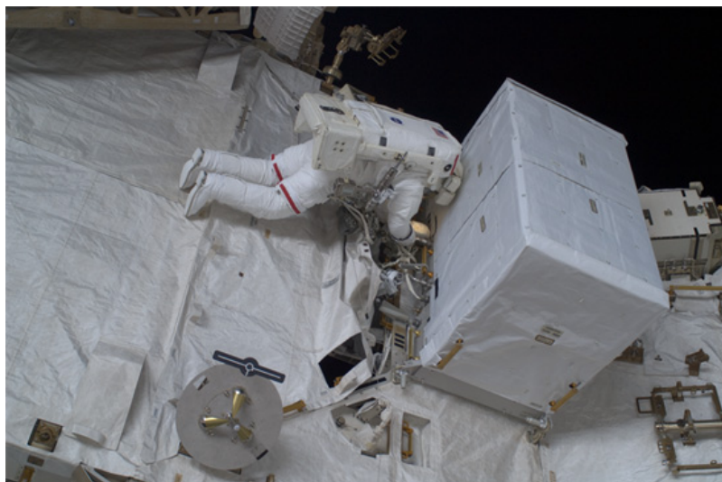
新しいアンモニアタンクをP1トラスへ取り付けしている様子（STS-128）
