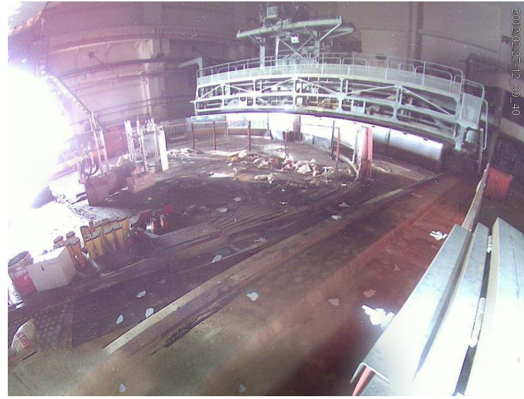
2号機オペレーティングフロア
