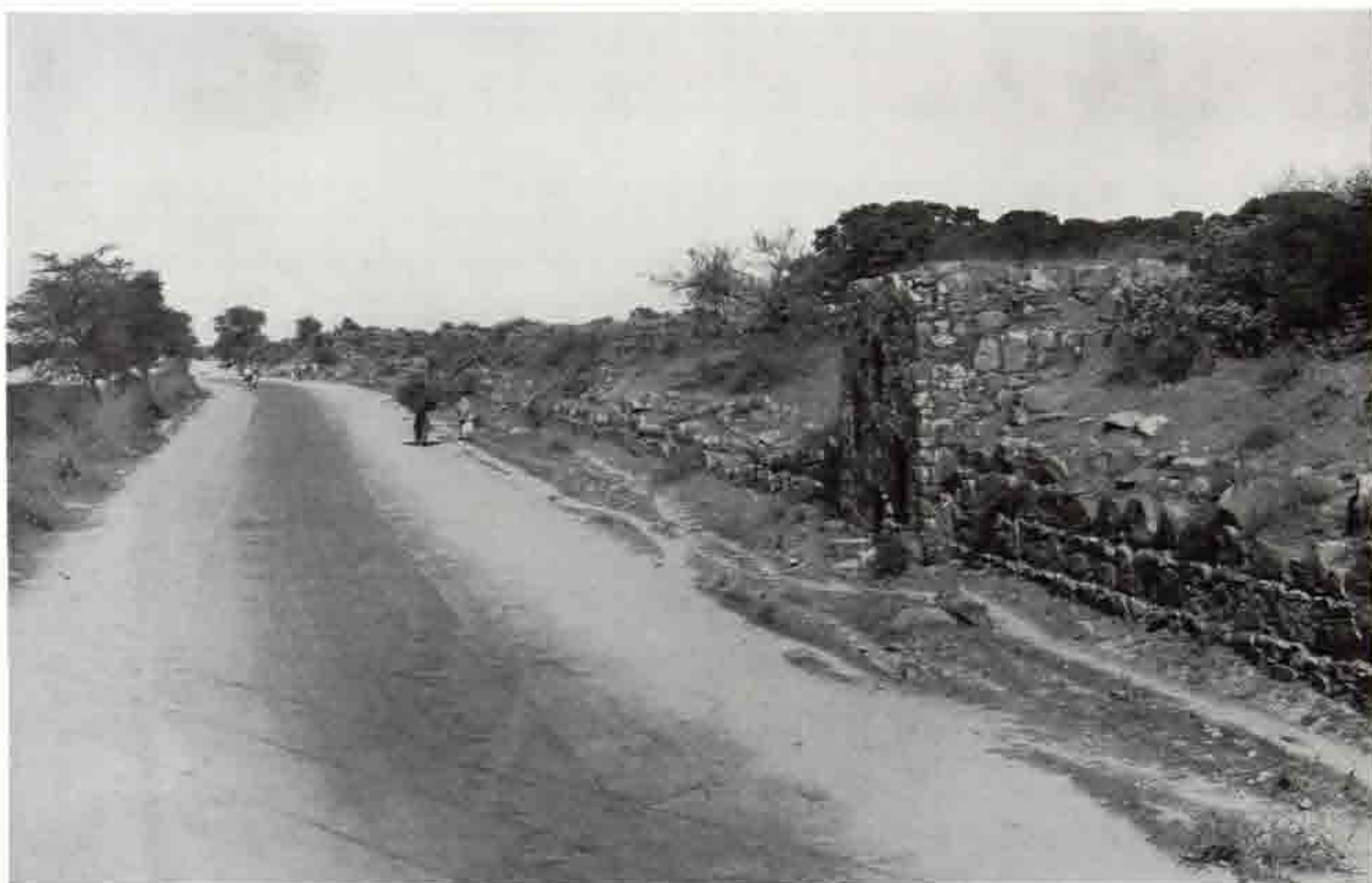
b W.44 同上 同部分 南東より
