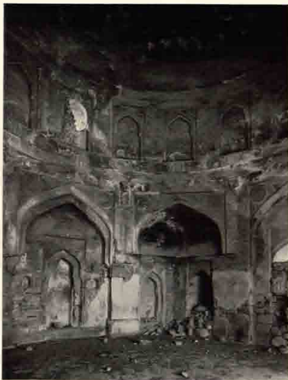
b M.34 同上 内部西北隅
