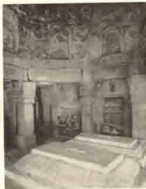
挿図 71 O.37 西側建物の内部 東北より
