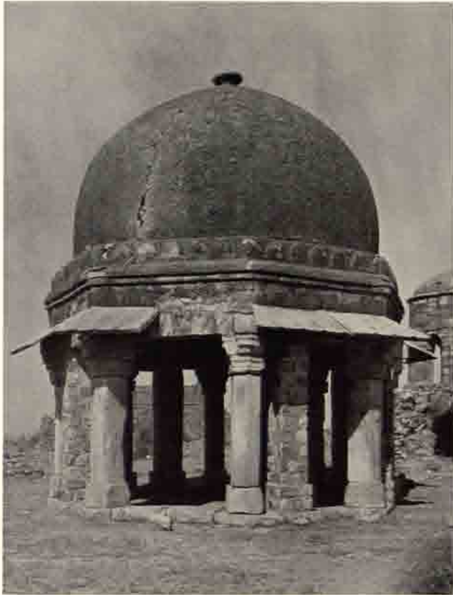
a T.92 ムイフズッティ-ソ-パヘラ-ムの墓 東南より
