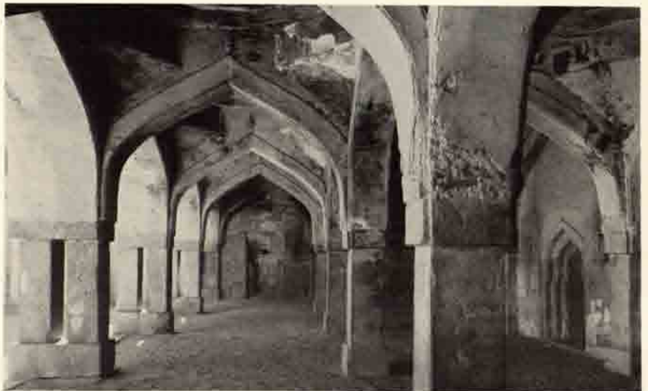
c M.32 同上 内部 北より
