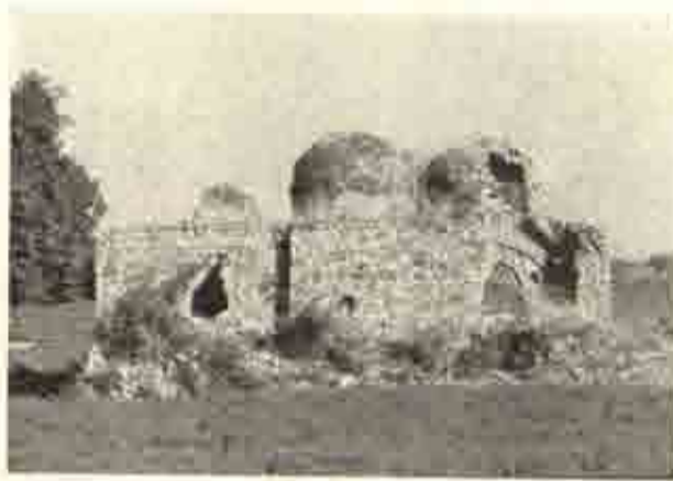
附図 9 M. 29. ドーム崩壊後の状態 西竹彦
