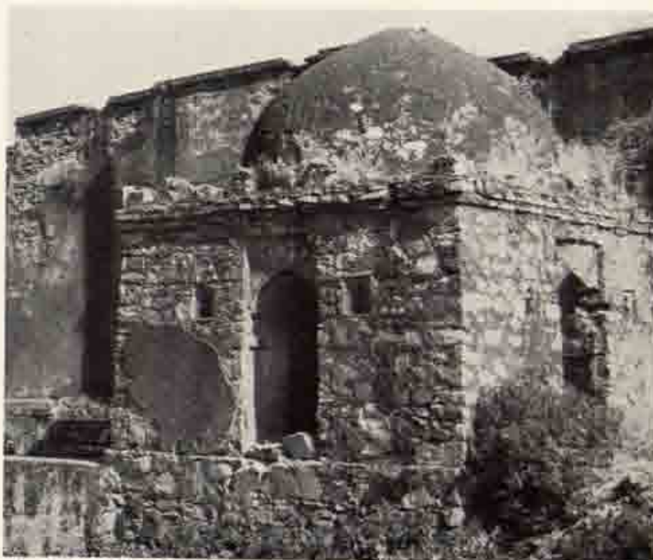
f T.21 墓建築(?) 西面と南面
