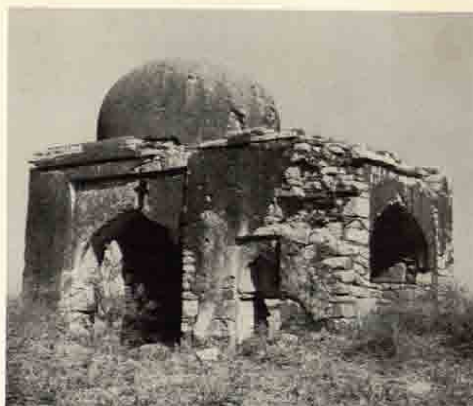
f T.15 墓建築(?) 西面と南面
