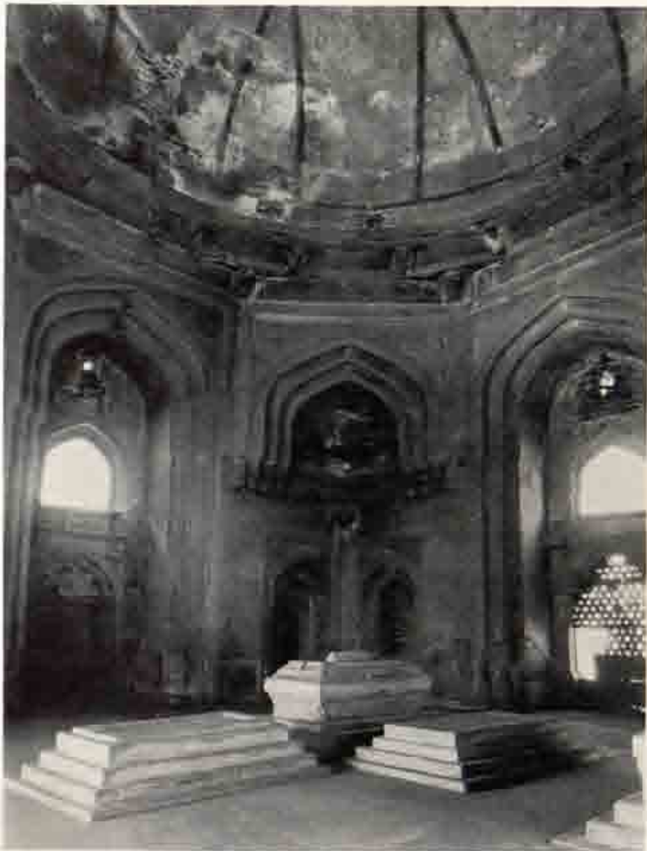
b T.54 同上 内部西北隅
