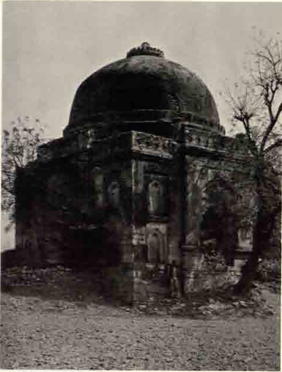
a T. 60 墓建筑 南面之西面
