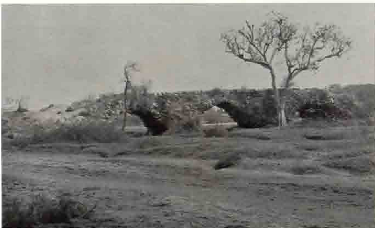
b W.51 橋 南より
