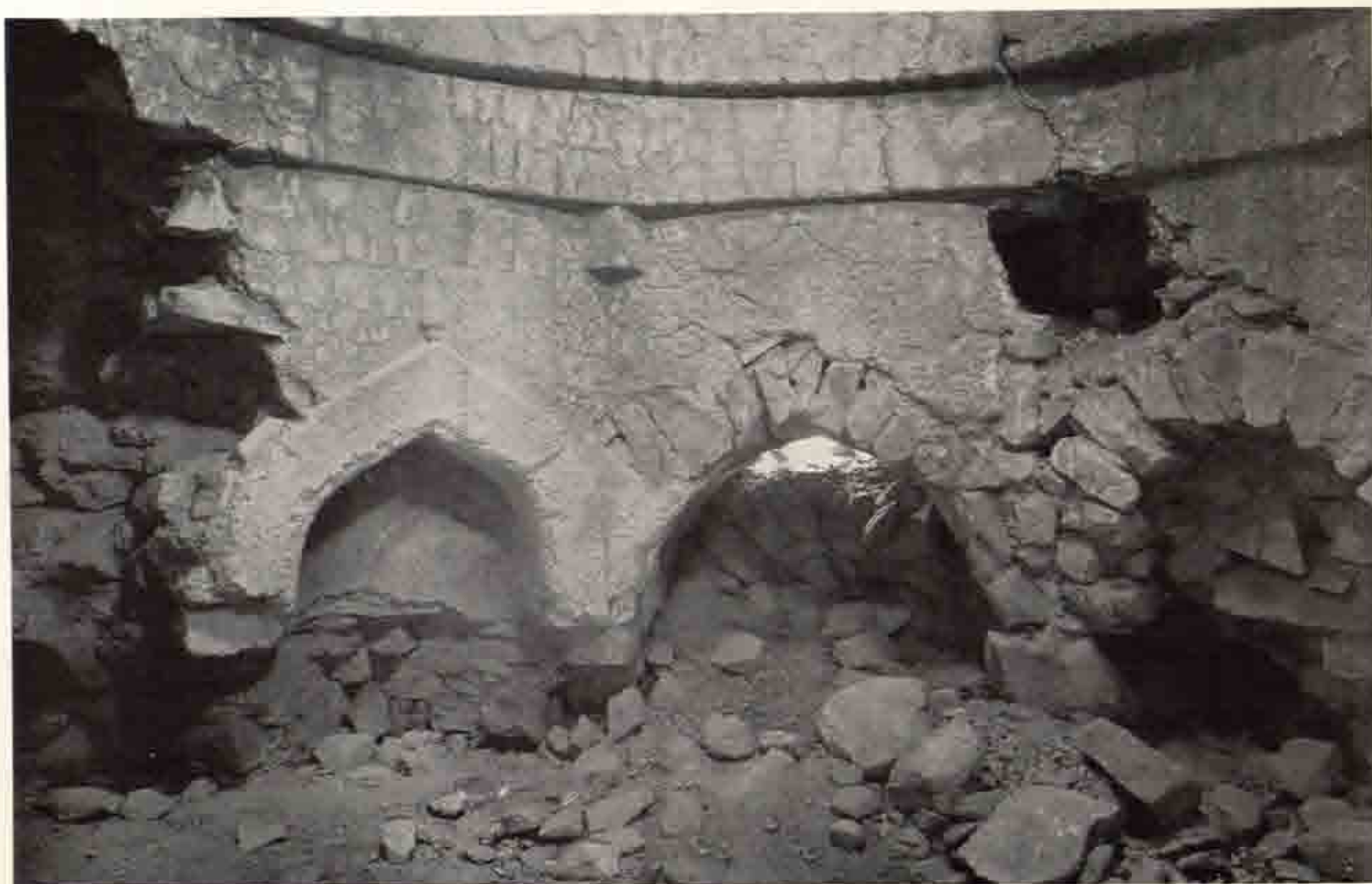
b. 0.51 同上 内部
