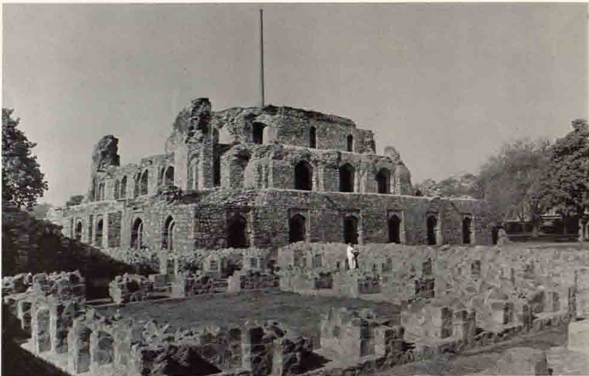
a O. 7. Palmyra 宮廷地城北部の所設状の建物 東南より
