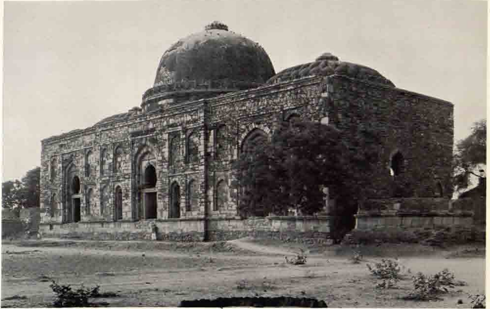
a T.71 エヘズマドブルのティーツーブルジー 東面と北面
