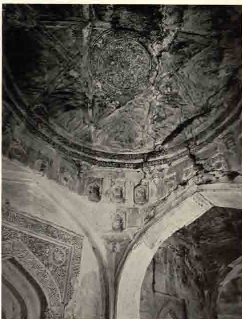
c M. 40 同上 西北隅と天井
