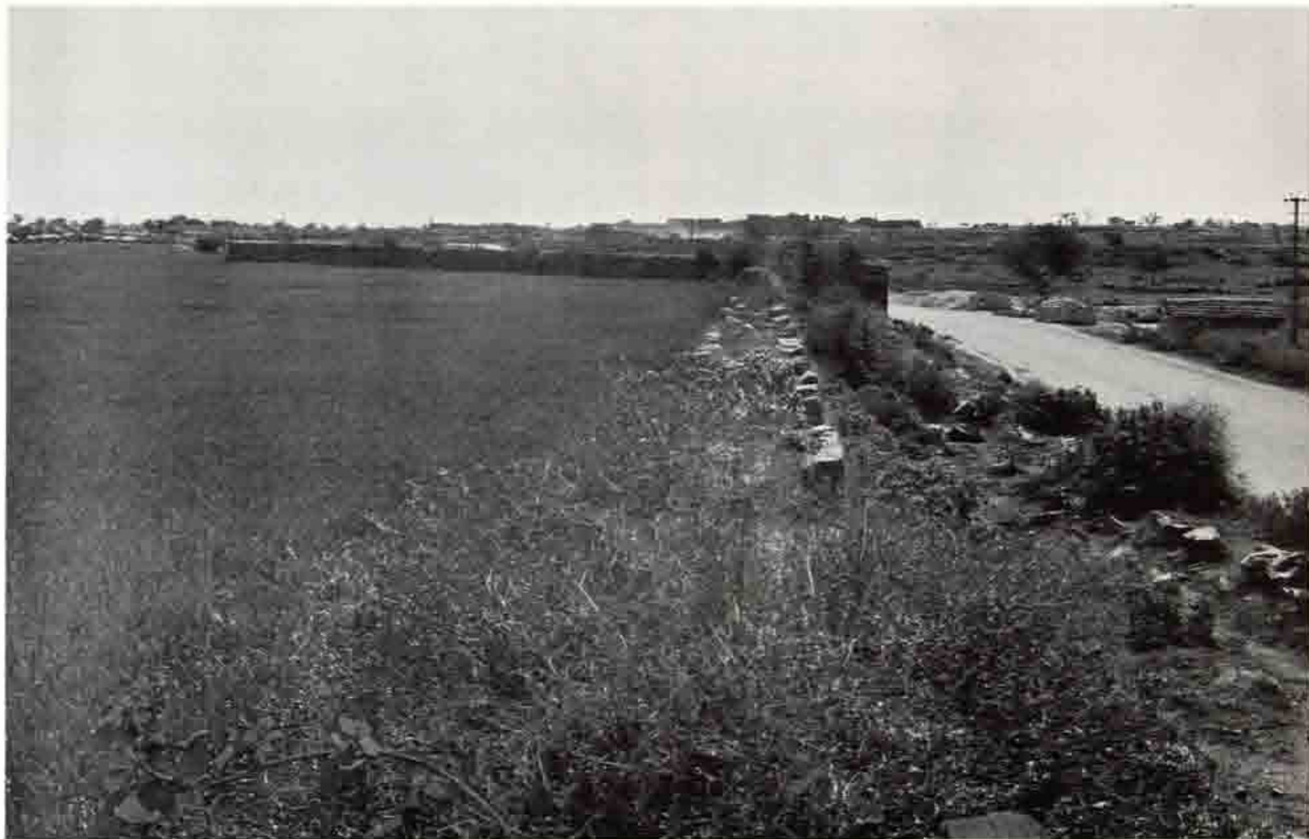
a W.44 マヒバールプルの被災 南の部分 西北より
