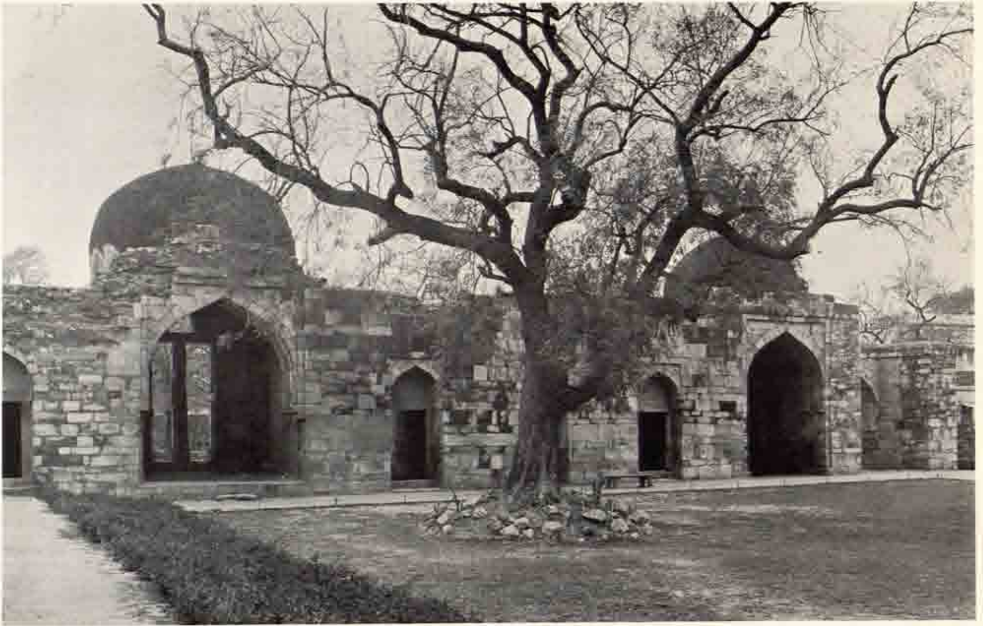
a O.23 アラー-クッディーンのマドラッサ 西側の部分 東面
