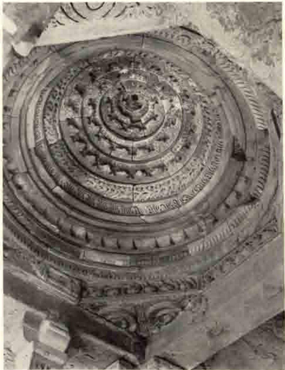
c M. 1. 同左 北廻廊中央部のドーム天井 内部
