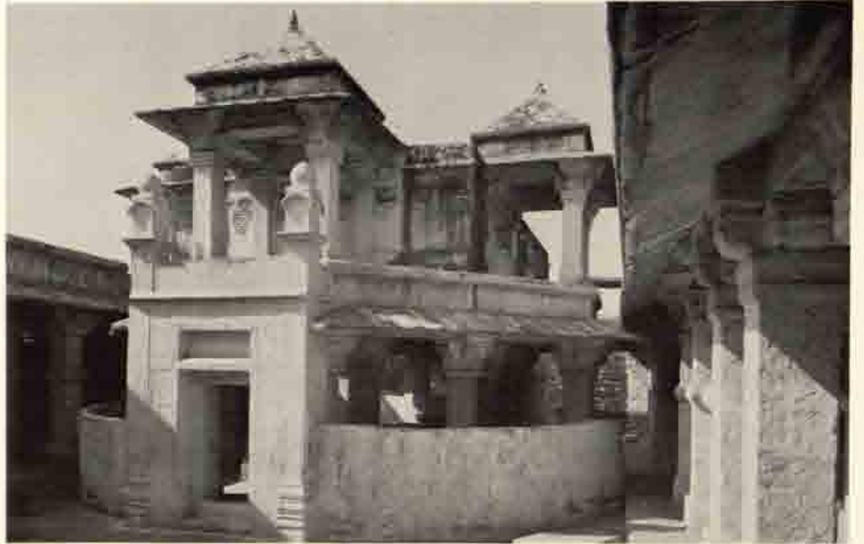
a T.99 カダムン・ン・サーフ 中央建物 前面
