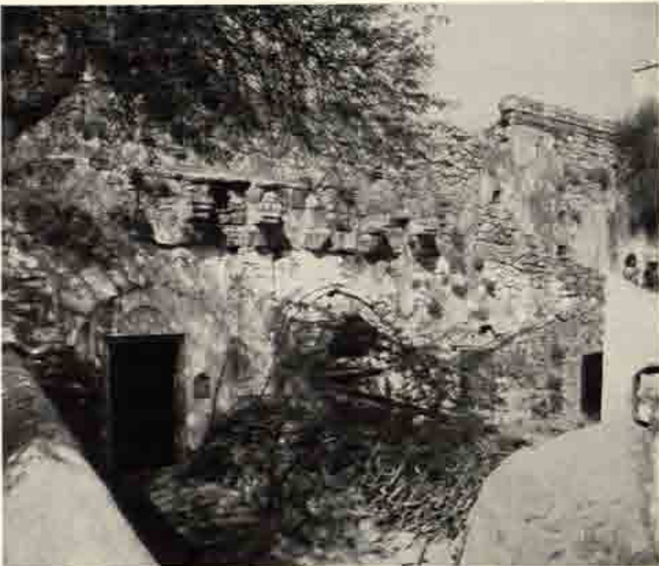
c O.26 ツーリーのバーサラー 東面
