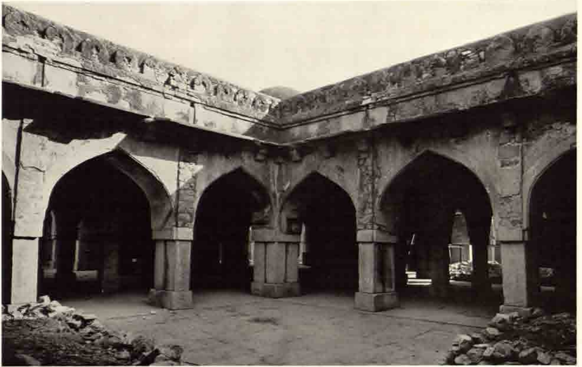
a. M.7 同左モスク 内庭と柱廊の一部
