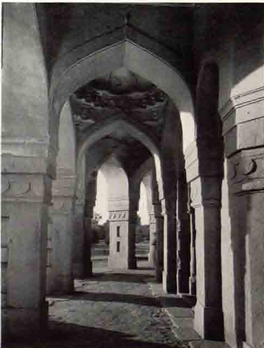
b. T.78 同上 廻廊の一部
