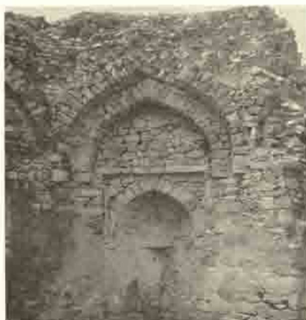
図版 20 T.3 主室内部のスライファアーチ
