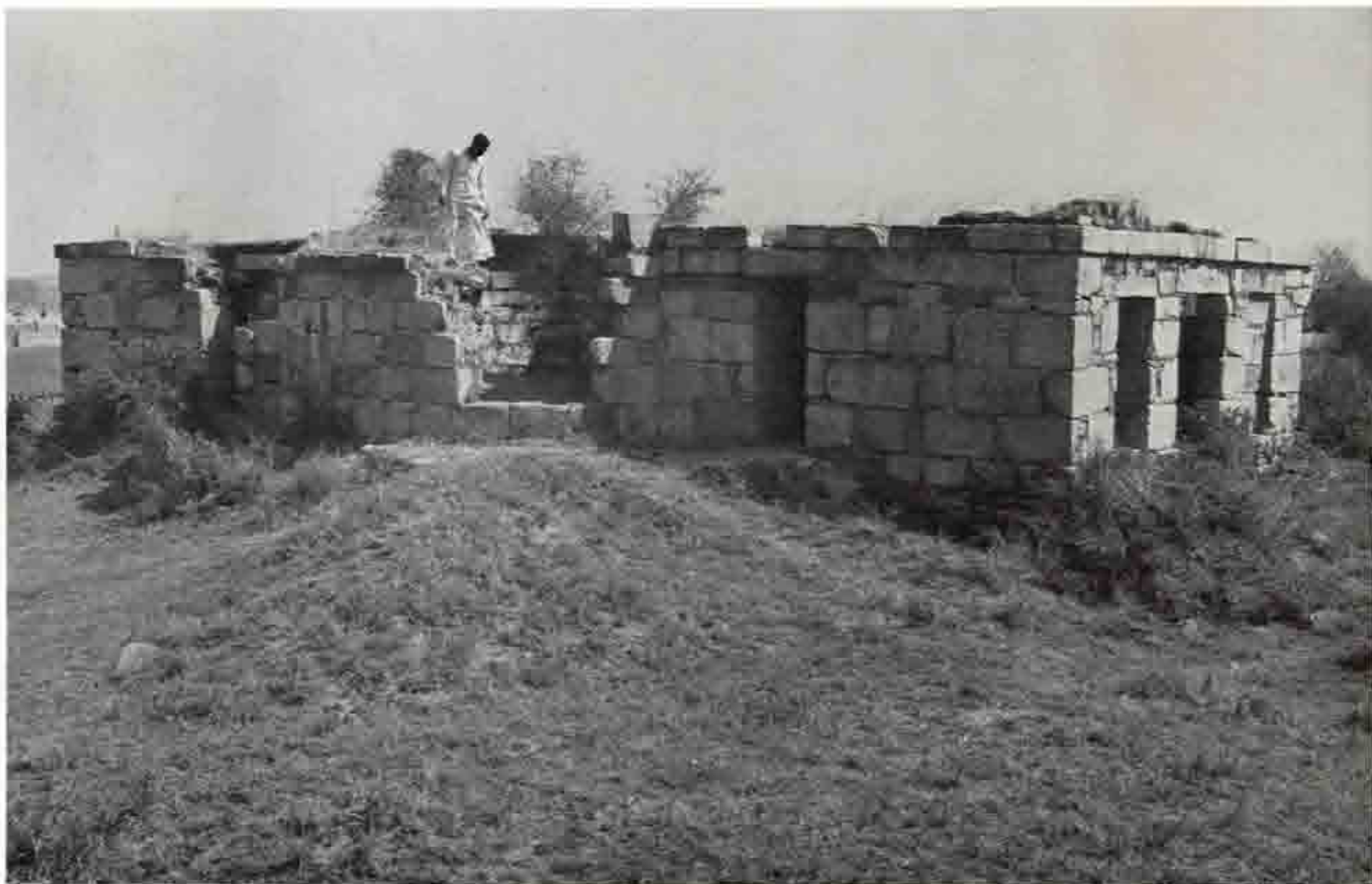
c W.24 同上 井戸の部分 西側より
