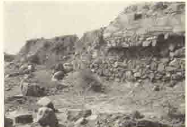
附図 65 O.10 一部の石積みの状況 ⅢⅢ
