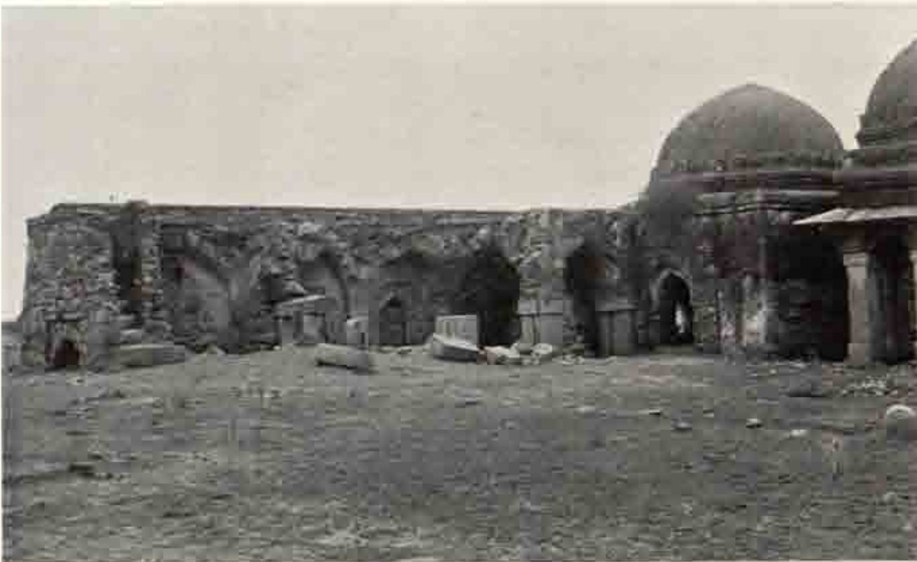
b O.32 宗教施設(?) 崩壊の状況 西より
