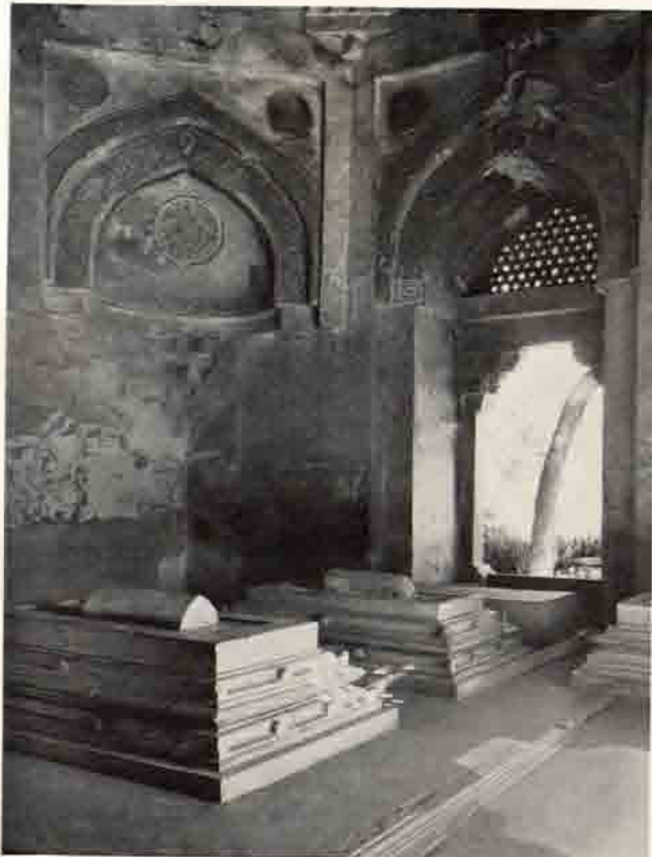
b T.9 同上 内部 北西隅
