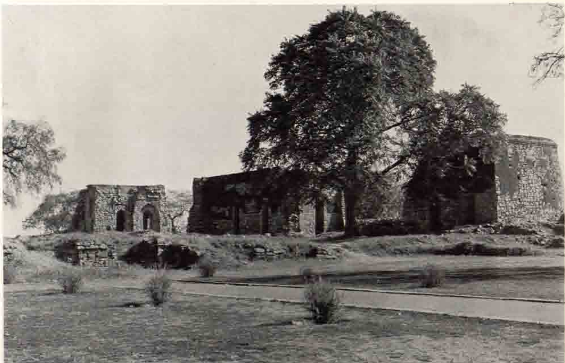
b O. 7. 同上 宮廷地城南部の建物 西北より
