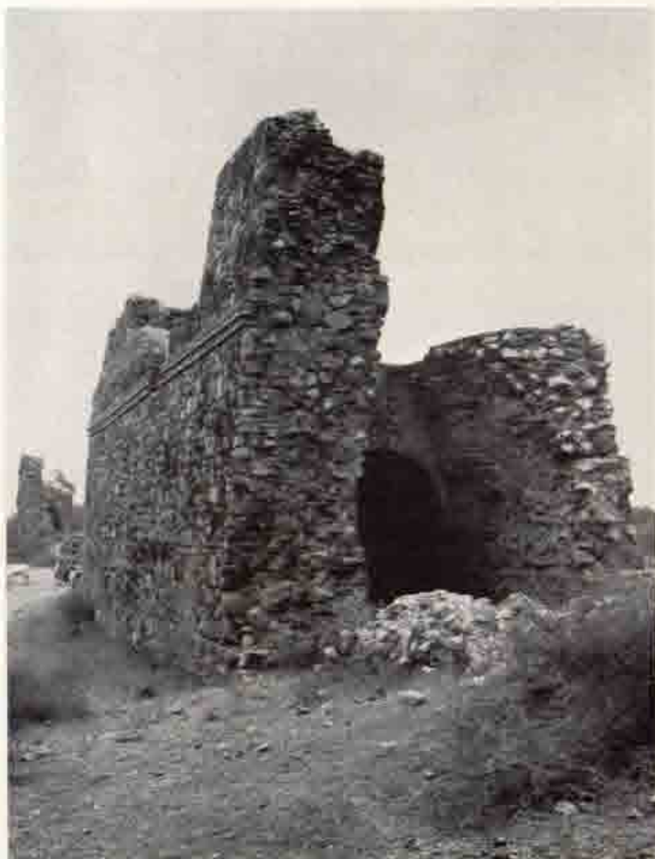
b. 0.1 同上 城壁の西の部分 南より
