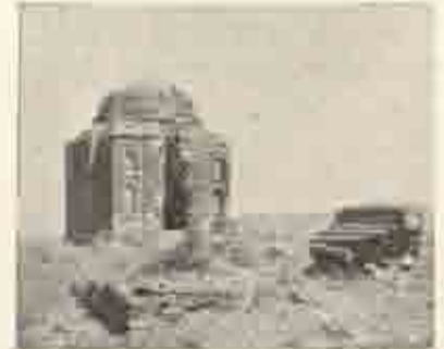
挿図 78 崩壊寸前の状態 (1955年) 南面
