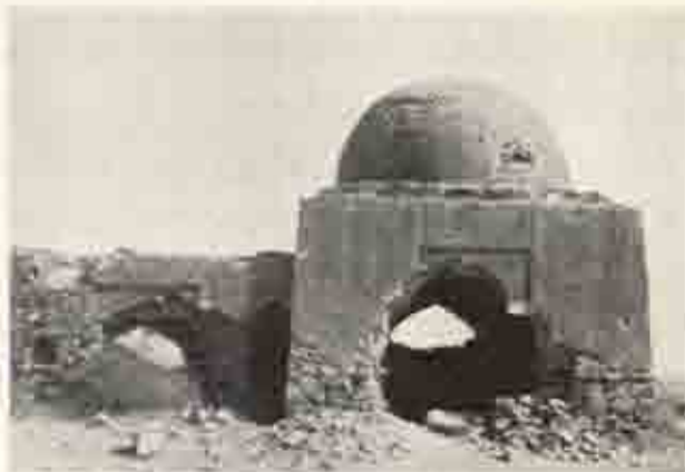
挿図 8 M.19 北上囲壁の北の部分の小建物 南面
