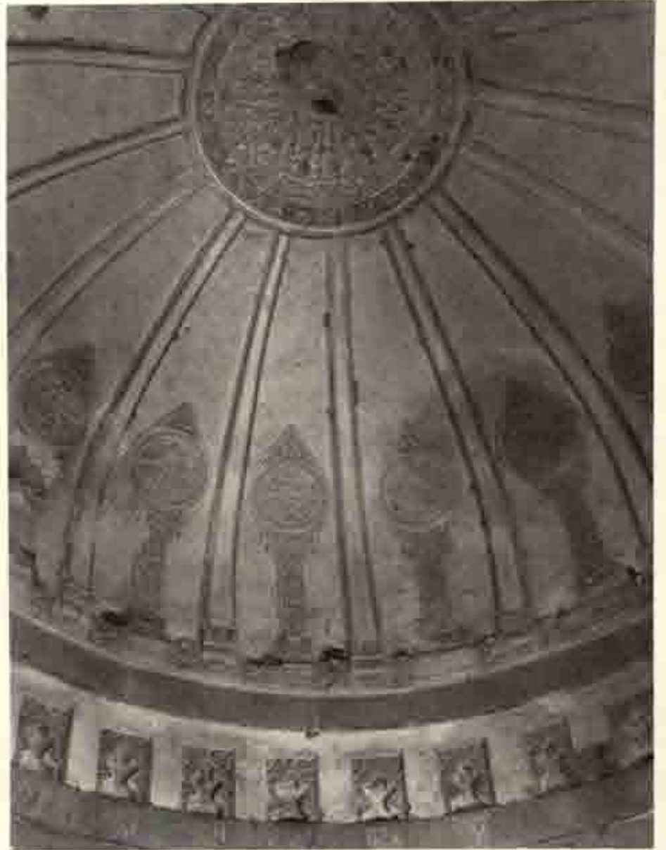
b. T.111 同左 ドーム天井
