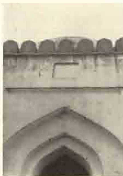
挿図 72 O.38 東面 入口上部
