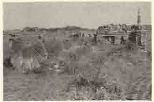
挿図 28 G.72 崩壊した門のドームと囲壁の一部 南より
