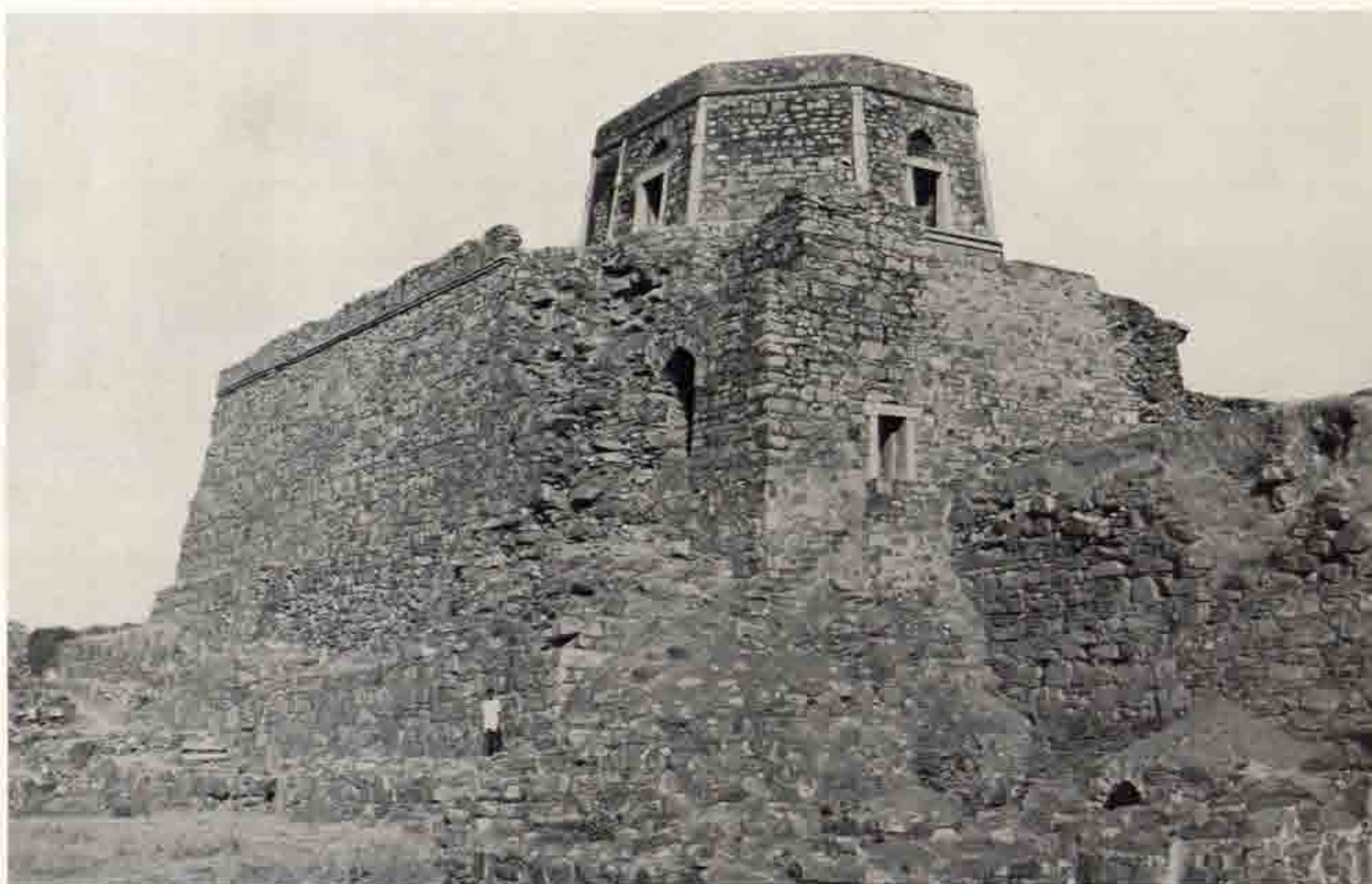
b O. 6 同上 鐘楼風の建物 西南より
