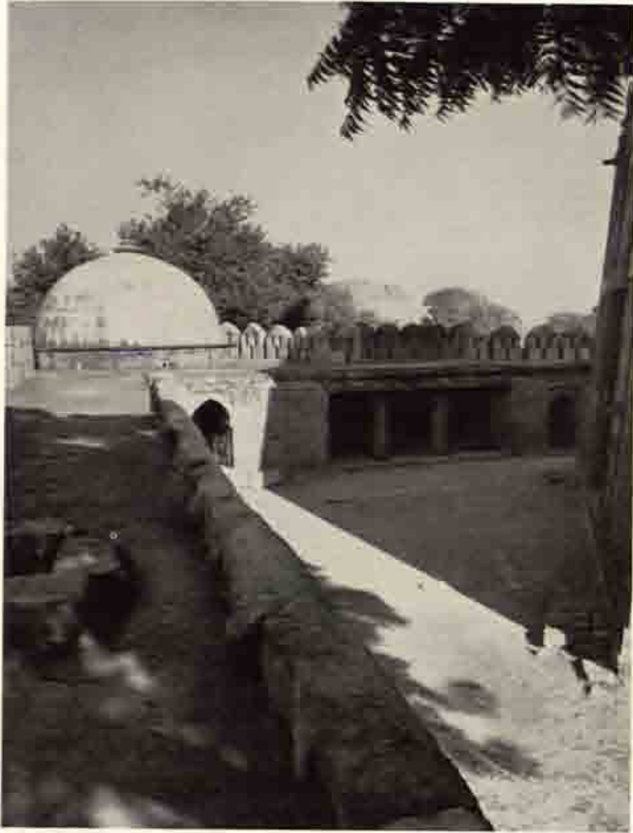
a. T. 7. ギファール・カーンの墓 西南より
