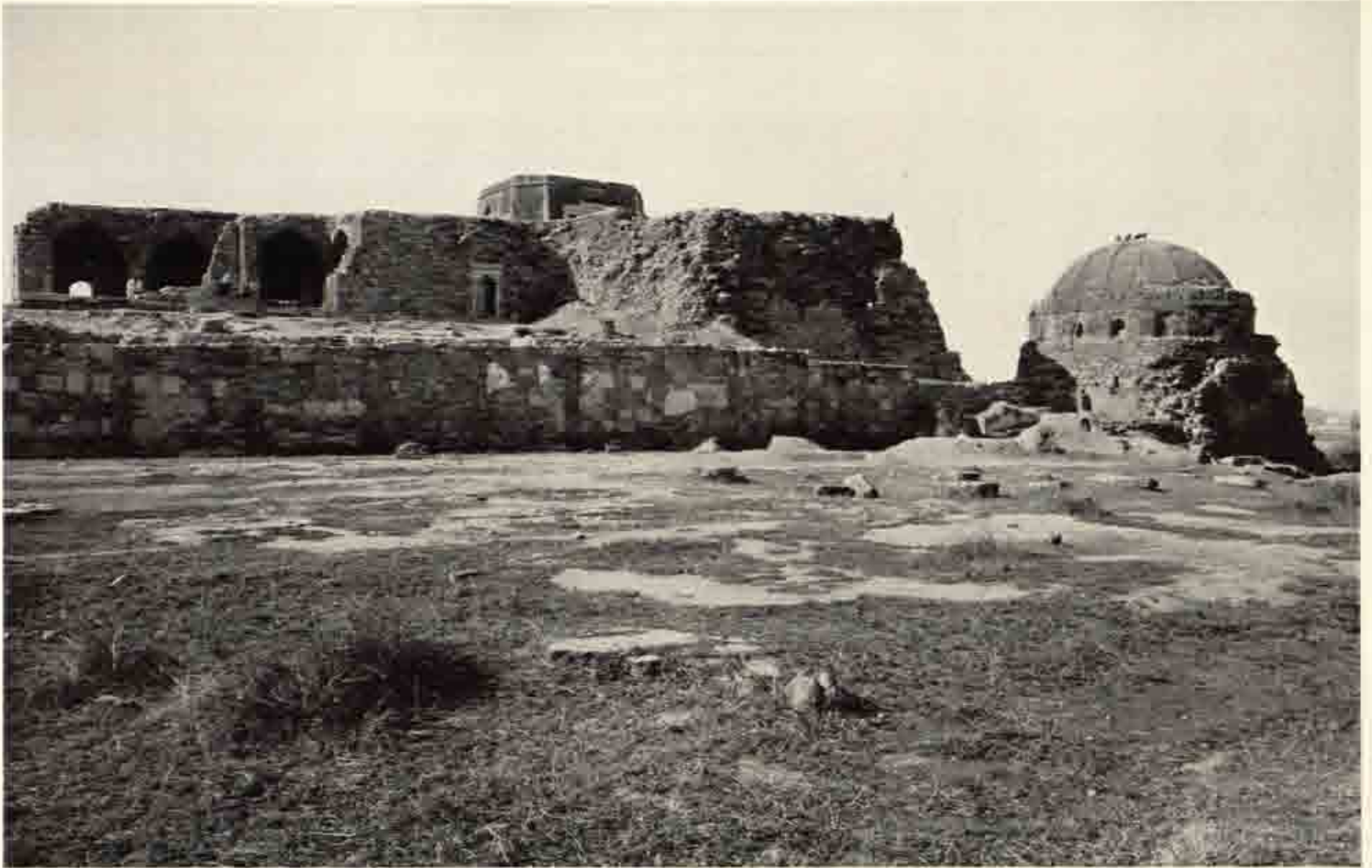
a O. 6 同左 主要部分 北より
