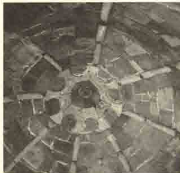
附図 35 T.114 ドーム天井
