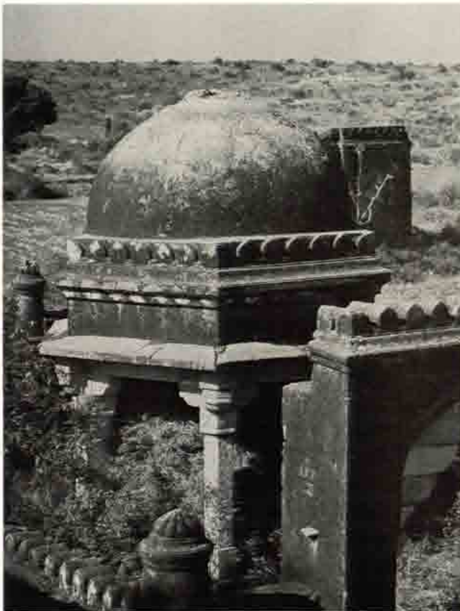
c. T.128 高建築 東南より
