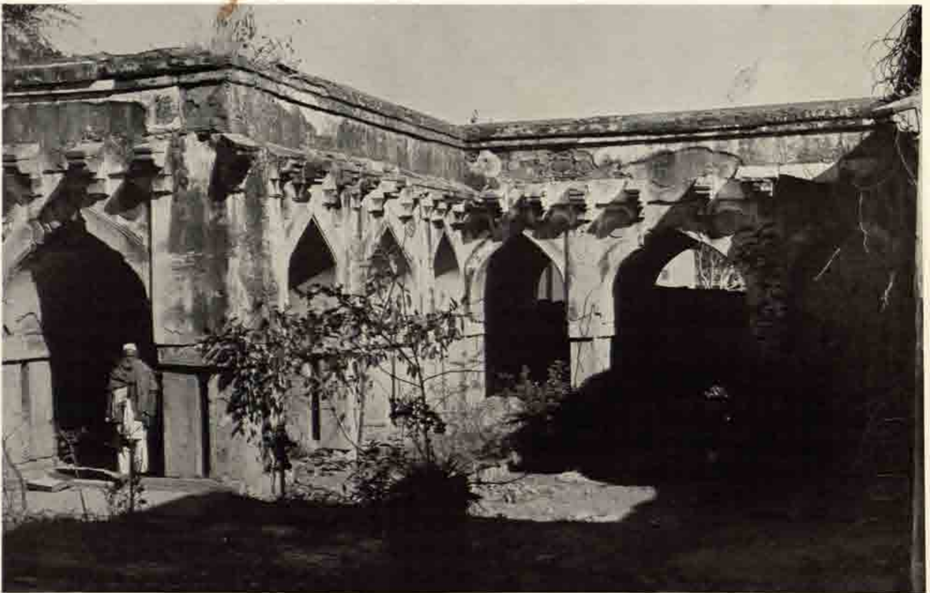
b M.12 同上 同建物 内庭に面する東北部分
