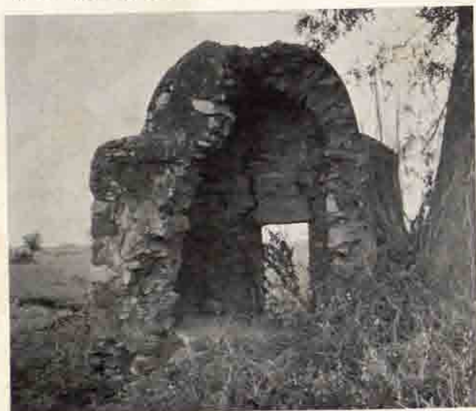
d O.57 不明の建造物 西南より
