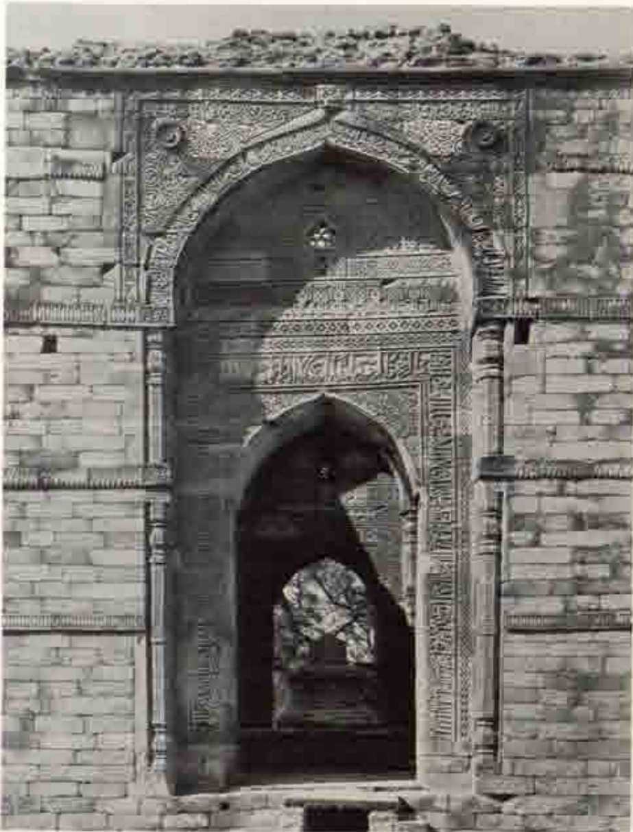
b. T. 2 同上 南面 中央部分
