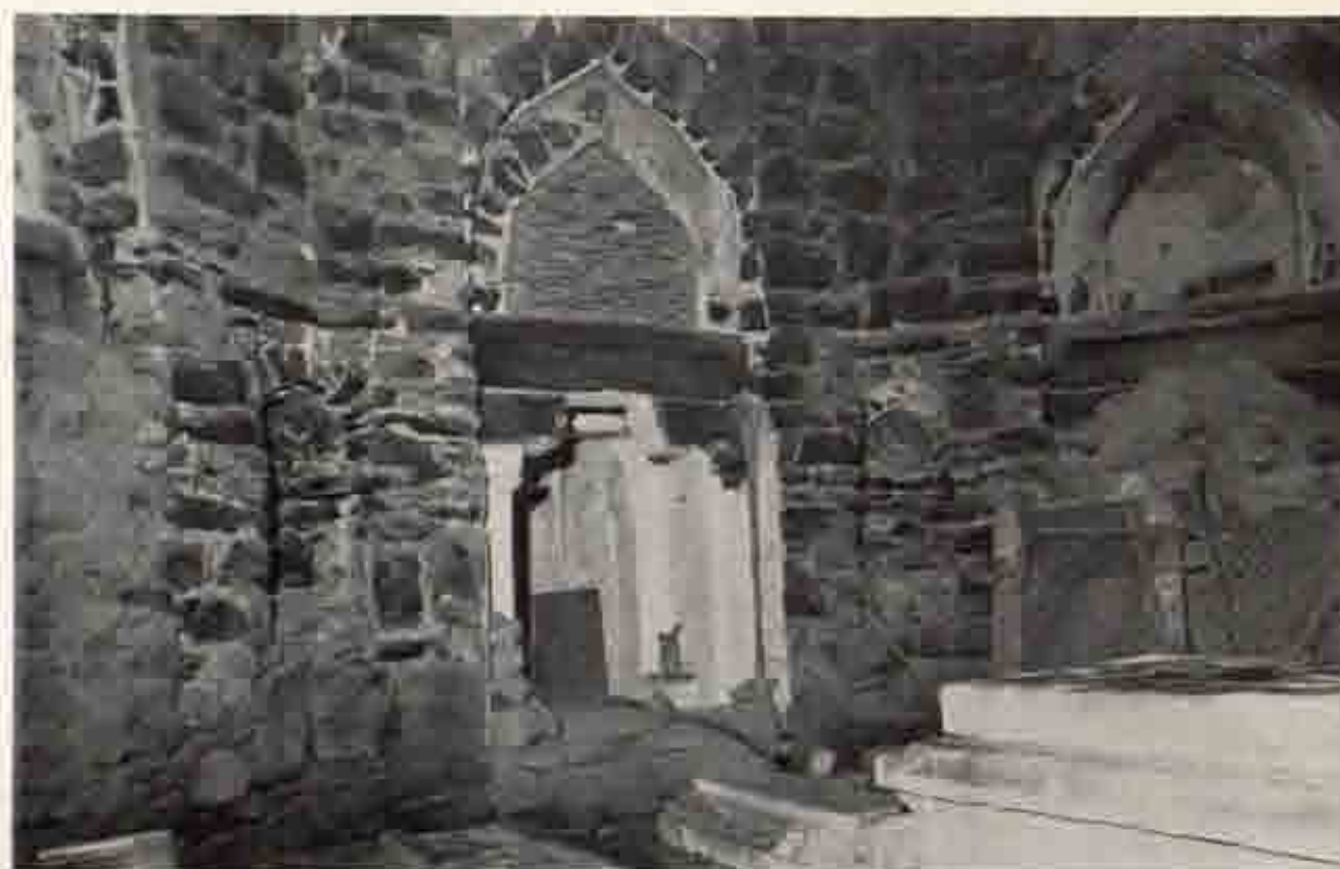
c T.76 同上 内部南側
