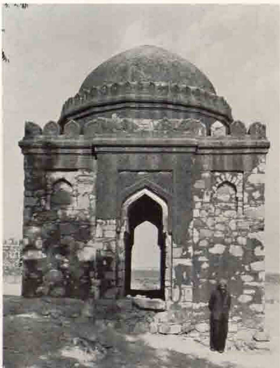
c T. 65 墓建筑 南面
