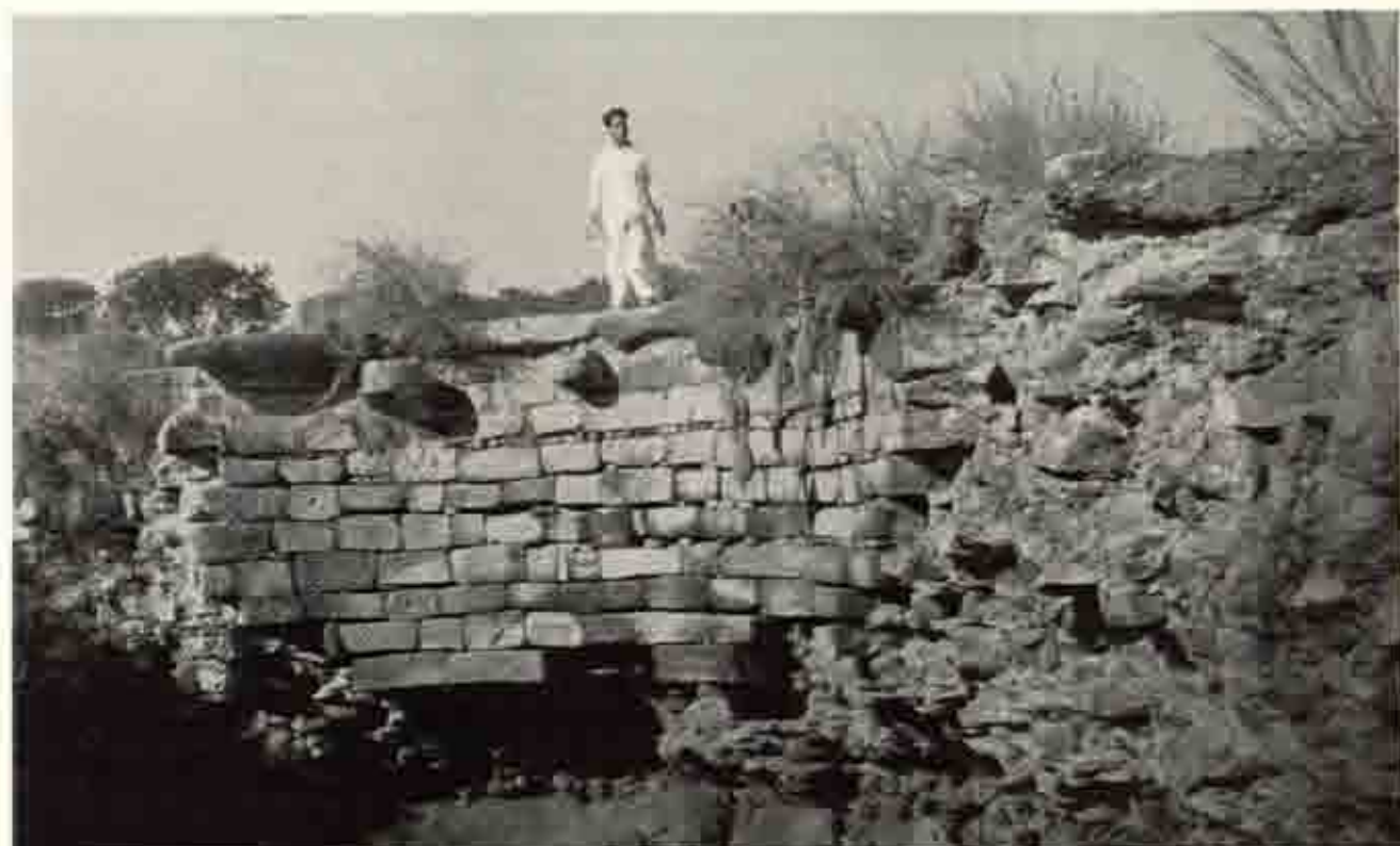
b W.12 グリーン=パークの円井戸: 現存する内部西南部分の石積み
