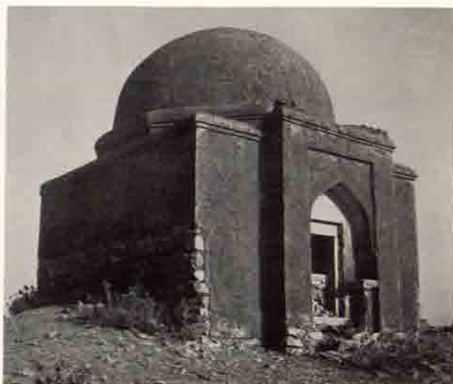
b T.17 墓建築(?) 西面と北面
