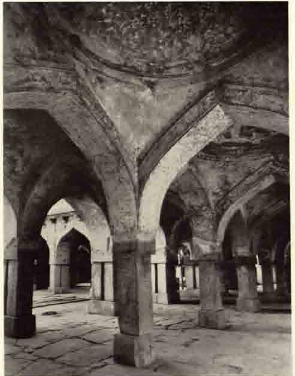
c. M.7 同上 柱廊 内面
