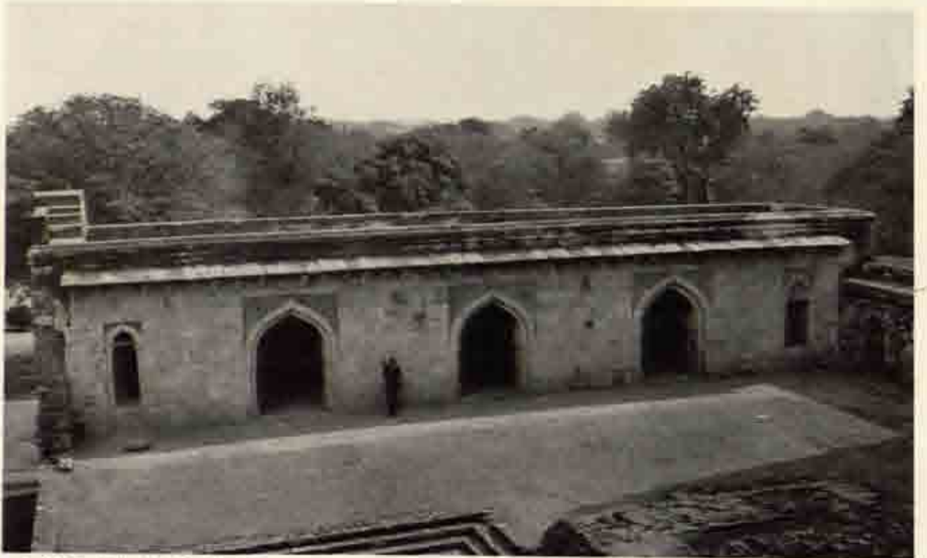
c M. 35 同上 東側の遺物 西面
