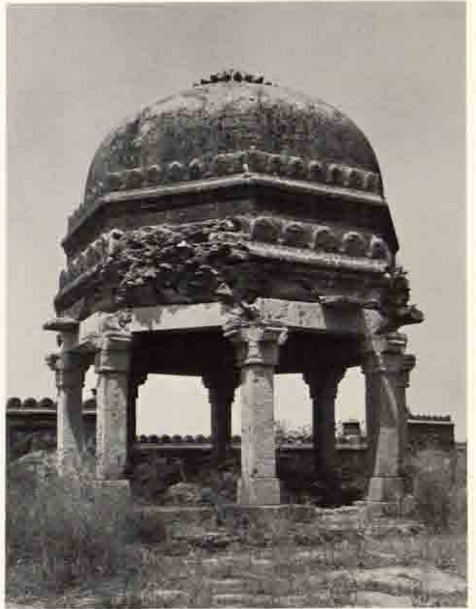
b T.106 墓建築 東南より
