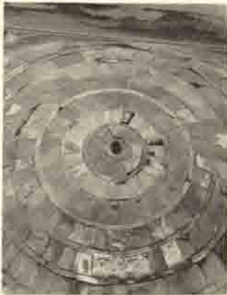
附図 34 T.109 ドーム天井
