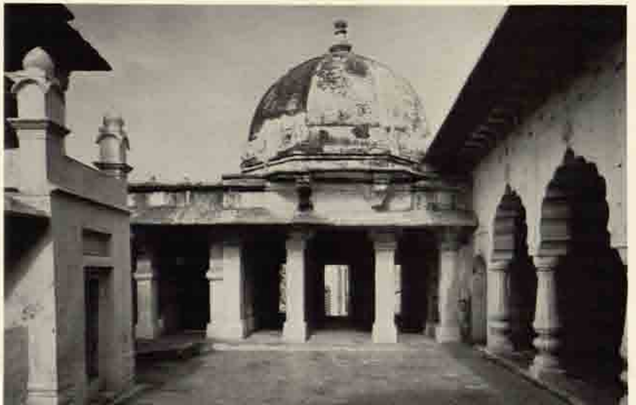
c T.99 同上 東北の十二本柱の部分 南側
