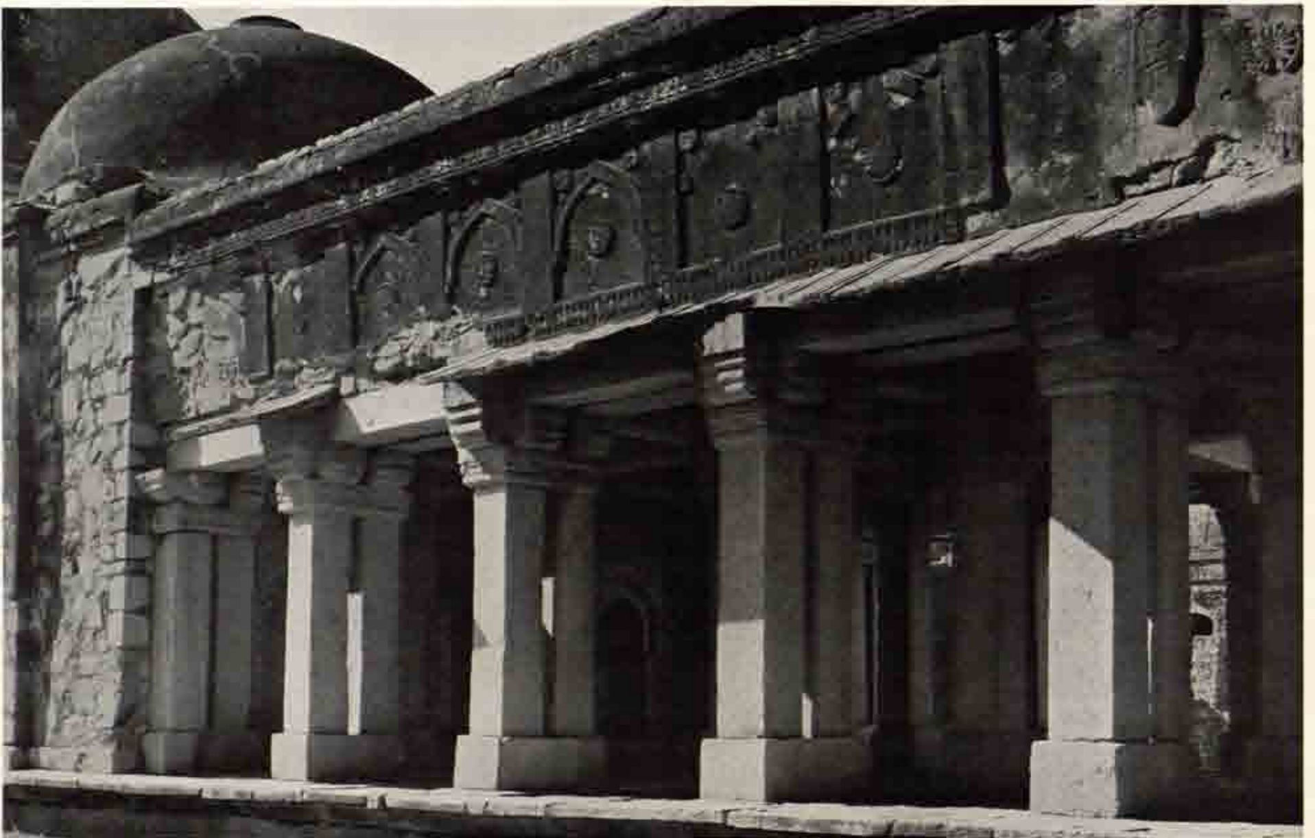
b O.24 同上 北側の部分、東面
