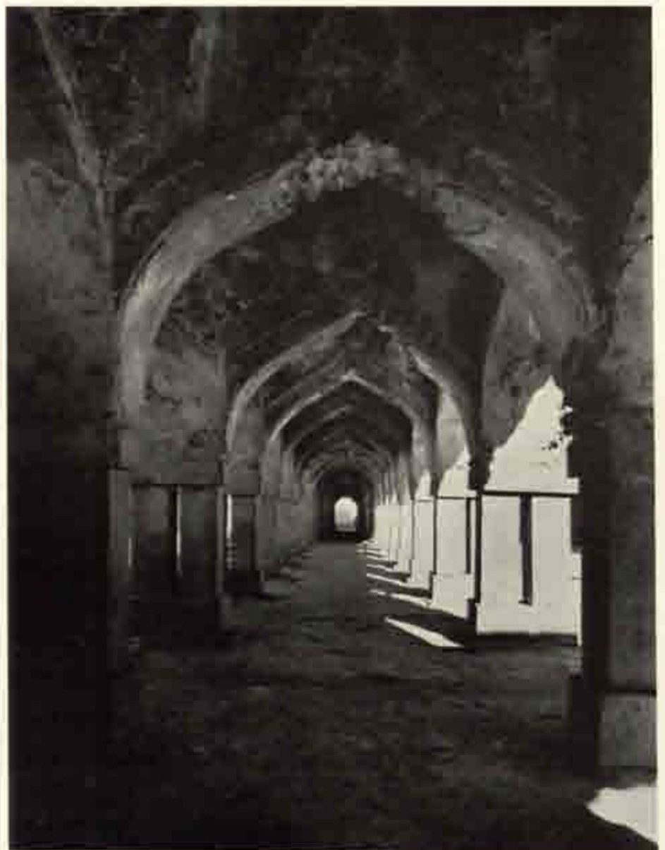
c M. 6 同上 通路 内面 南より
