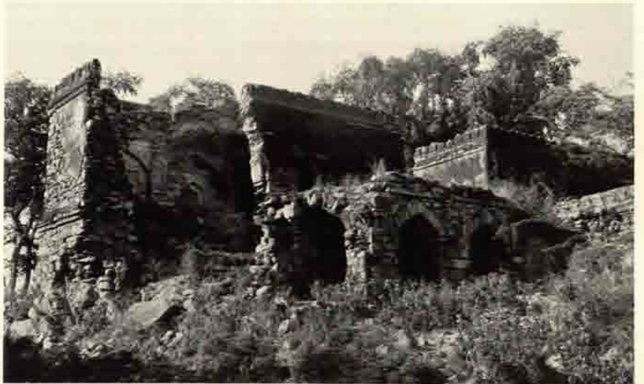
b M. 50 モスク 崩壊の状況 東南より
