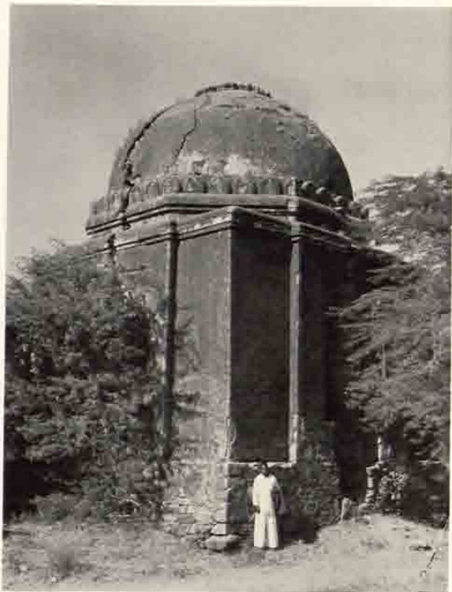
b T.30 墓建筑 南面と東面
