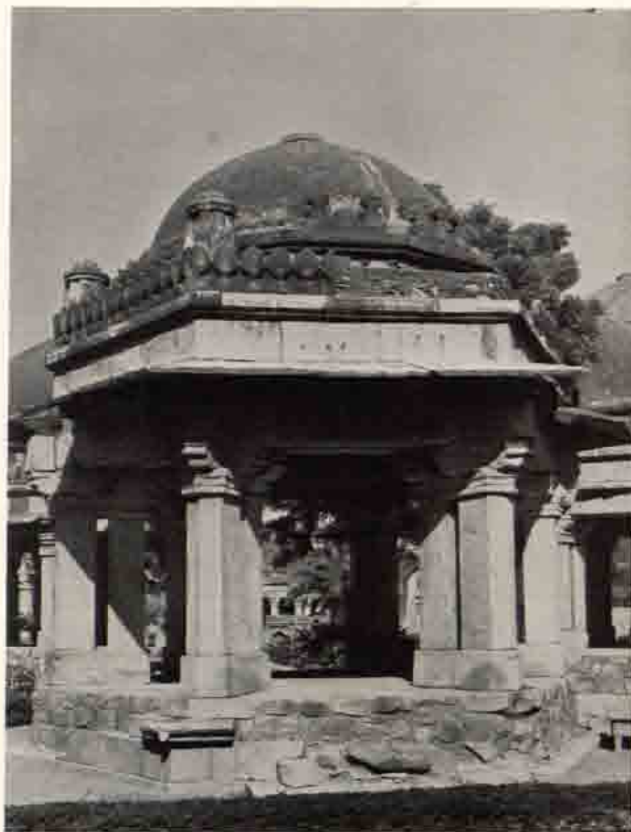
b T.97 墓建築 東南より
