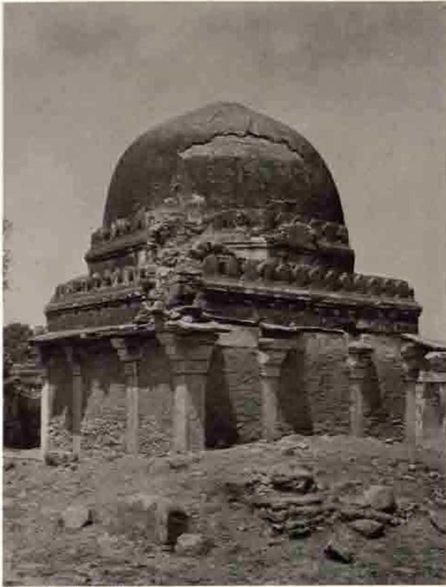
a. T.84 墓建築 東面と南面
