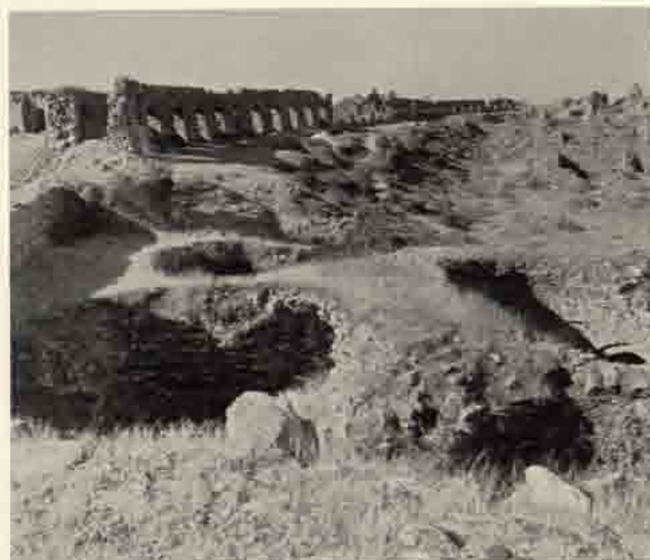
d O.53 アーディラーバードの地下倉 別築した上部の状態
