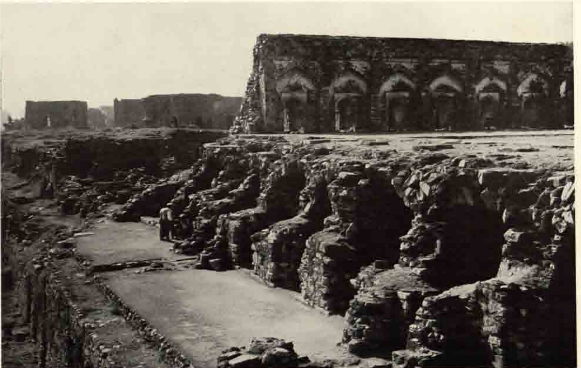
b M. 5 同上 崩壊した東側の部分と内部南側の一部
