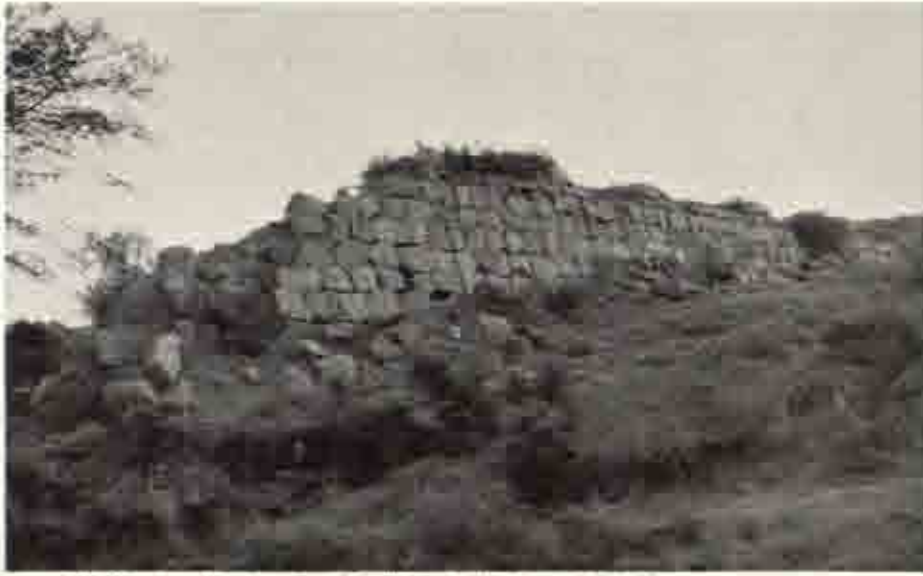
a W.36 トッブルカーブドの塼壁 残存する西面の石積み
