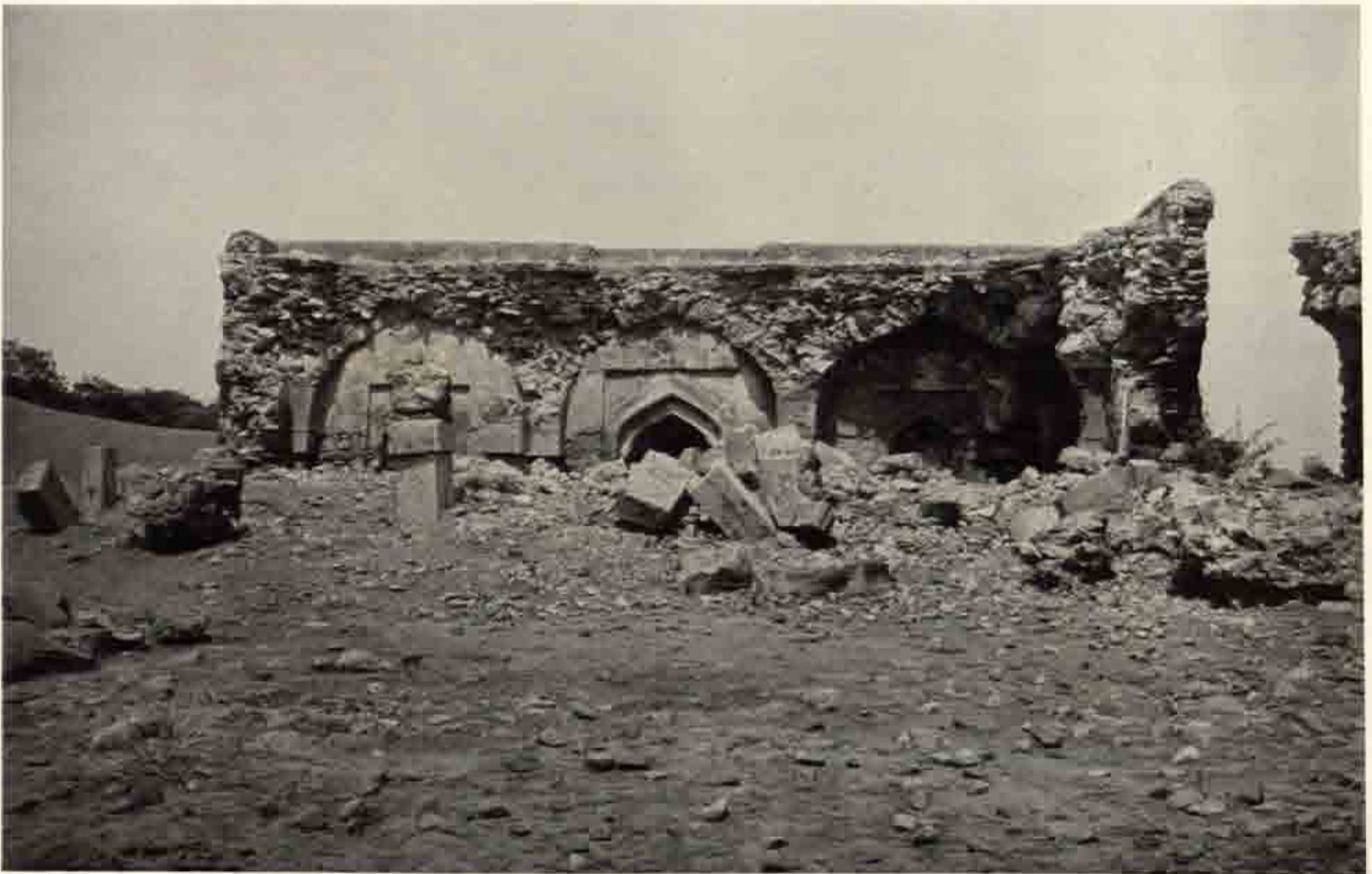
b. M. 23 モスク 崩壊の状態 東より
