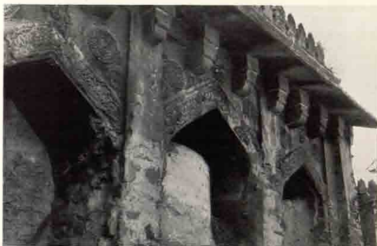
b T.76 同上 東北面 部分
