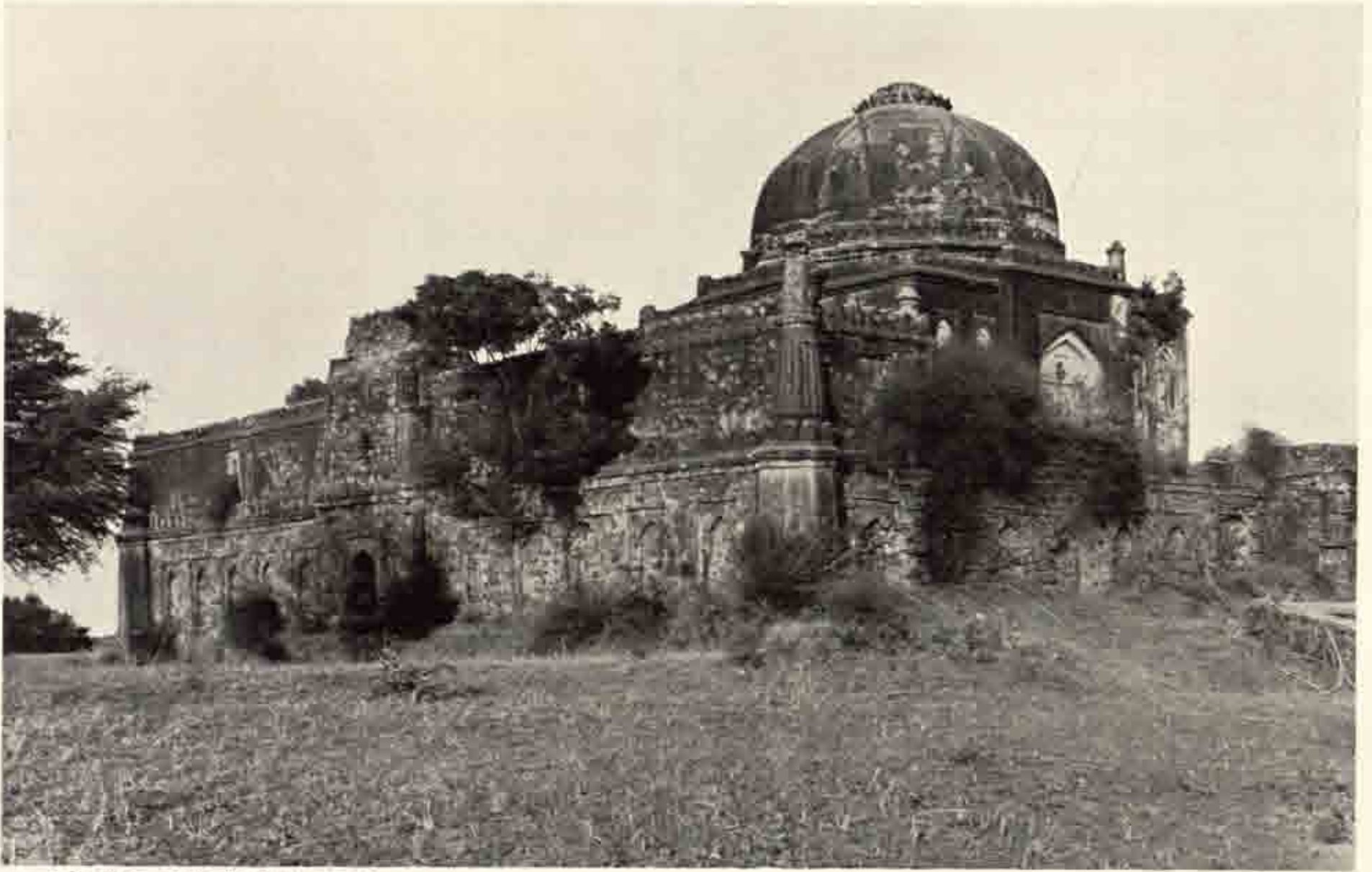
a T.52 高建築 同建物と附属礼拝堂 西南より
