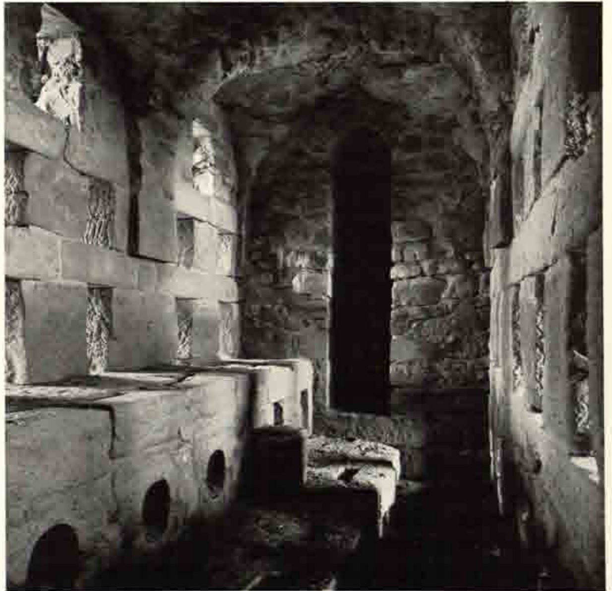
b. W. 49 同上 内部北側
