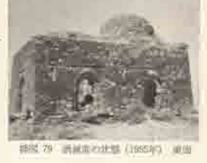
挿図 79 崩壊前の状態 (1955年) 東面
