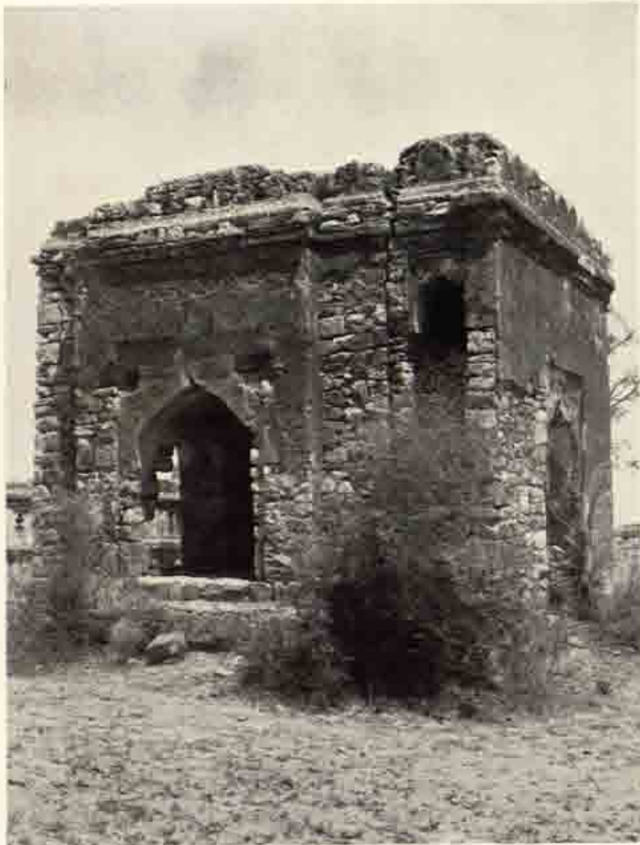
c O.47 不明の建造物 西面
