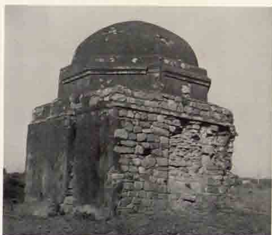
f T.40 墓建築 南面と西面
