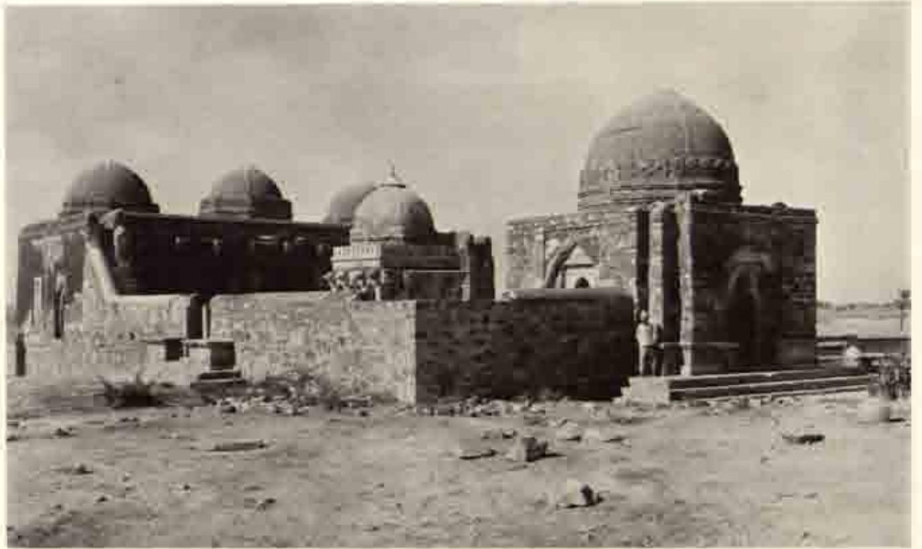
a M.18 ラジャーラーバードのモスク 東南より
