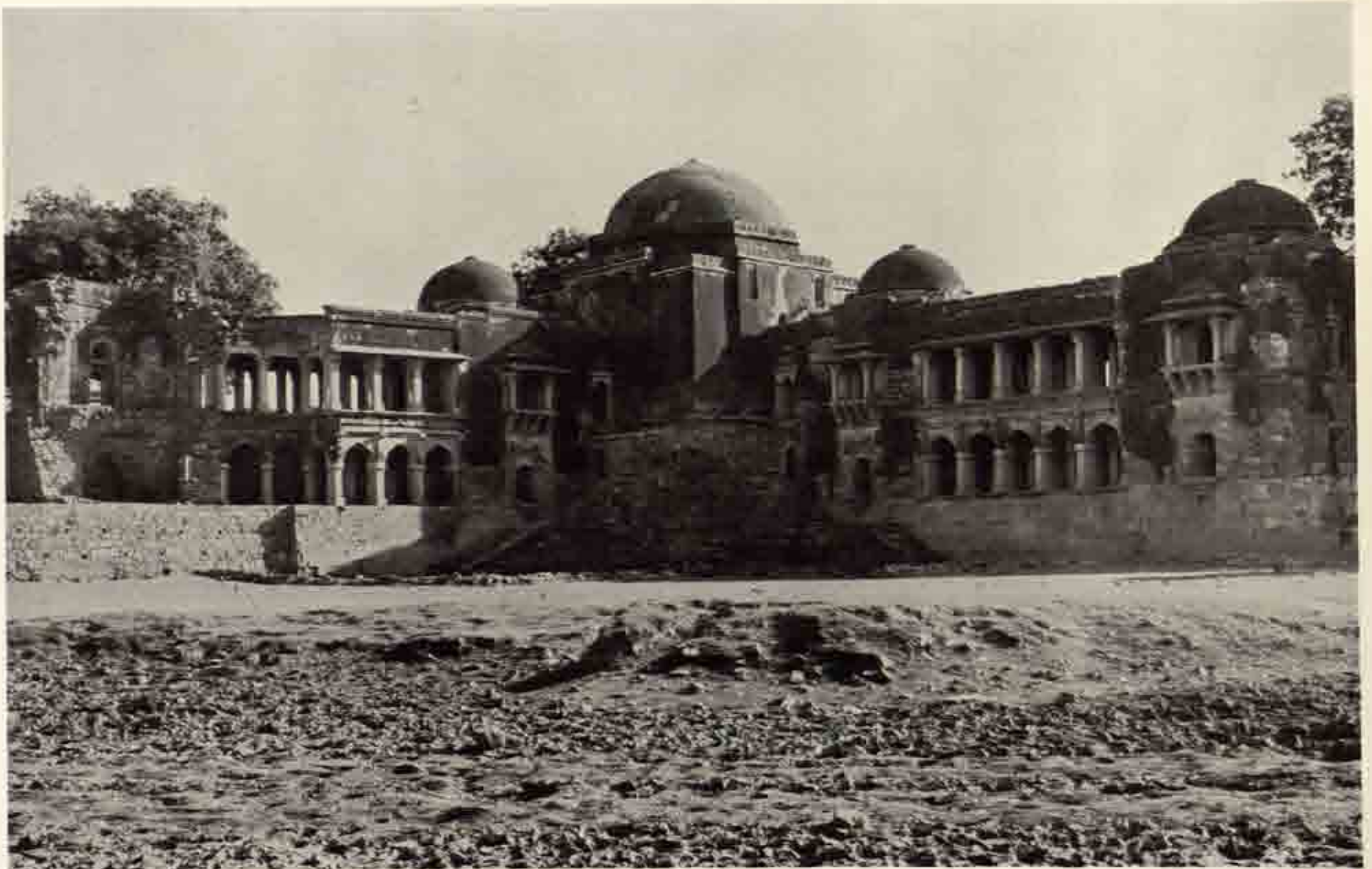
b O.24 同上 中核部分 西北より
