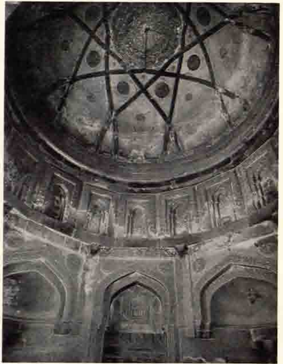
b T.50 同左 内部西側とドーム天井
