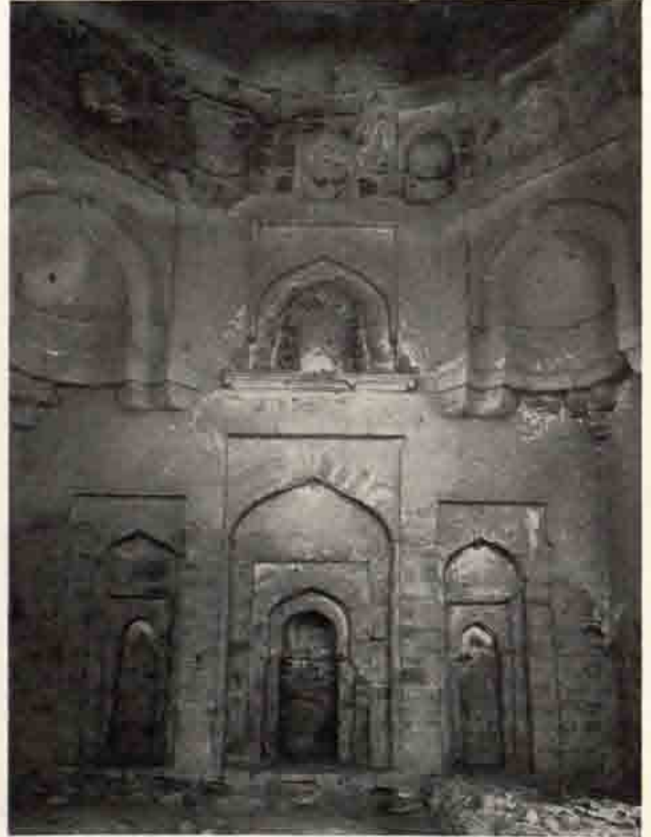
c M.10 同上 中央礼拝堂 内部西側
