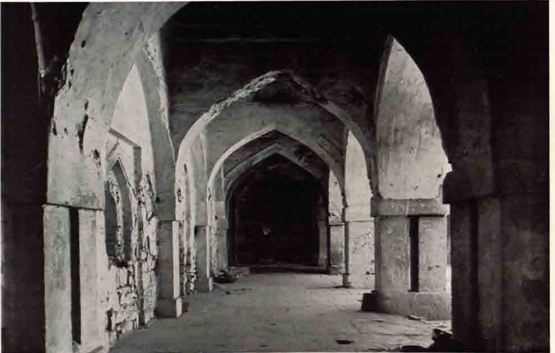
b M.13 同上 礼拝室 内部 南より
