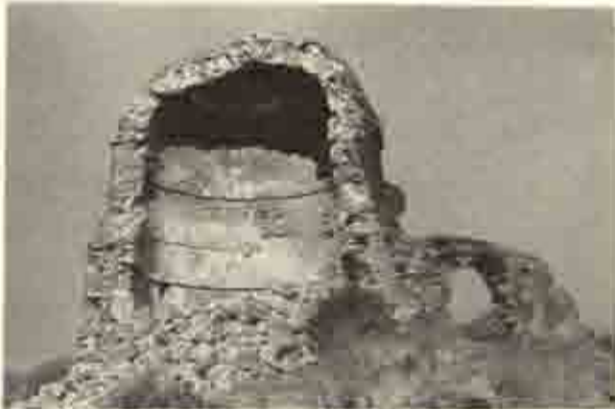
挿図.21 G.10 西南隅の塔のなかば倒壊した状態
