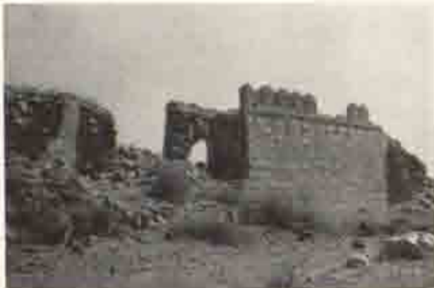
挿図 7 M.19 東方にのこる囲壁の崩壊部分
