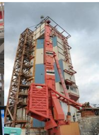
M整備塔改修
