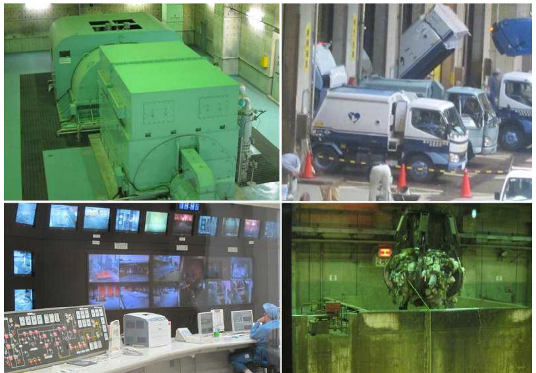
最新鋭の横浜・金沢清掃工場。ゴミ搬入ピット（右上）。自動化された炉へのゴミ投入装置（右下）。ゴミ発電タービン（左上）。コンピュータ制御室（左下）。
