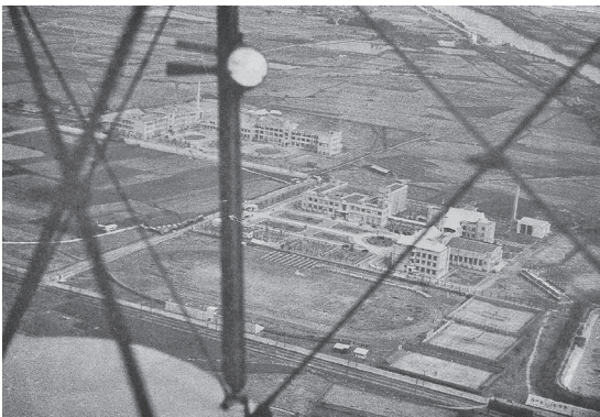
図15-1：久野機より撮影した杉本学舎の空撮
