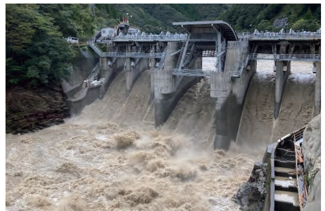
九州電力株式会社山須原ダム(耳川) における通砂運用の様子
