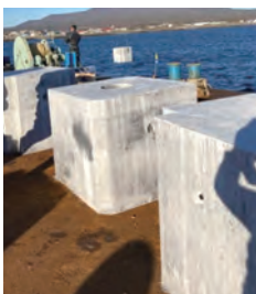
2トン級FSBの沈設
