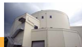
現在の棕野換気塔
