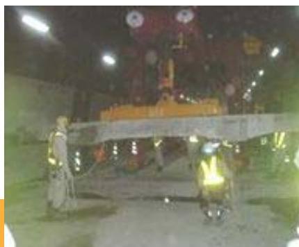
床版の撤去・床版鉄筋の設置
