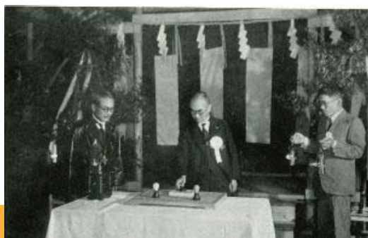
昭和17年5月 本トンネル導坑貫通*
