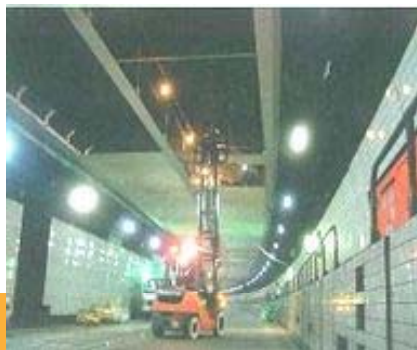
天井板の撤去・設置
