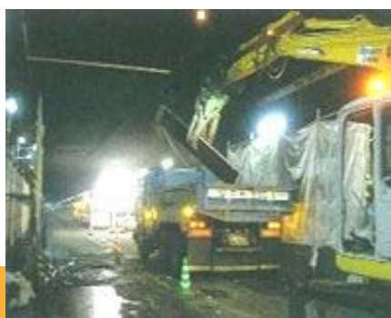
天井板の撤去・設置
