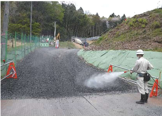
写真① 工事施工ヤード等の清掃、散水
