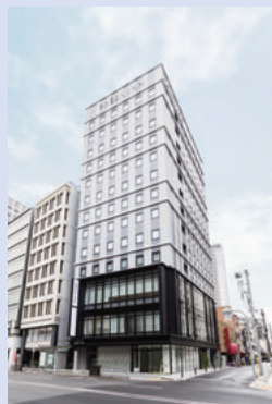
相鉄フレッサイン 淀屋橋
