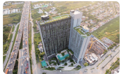
建設中のa Space Mega I（右）と同II（左）
